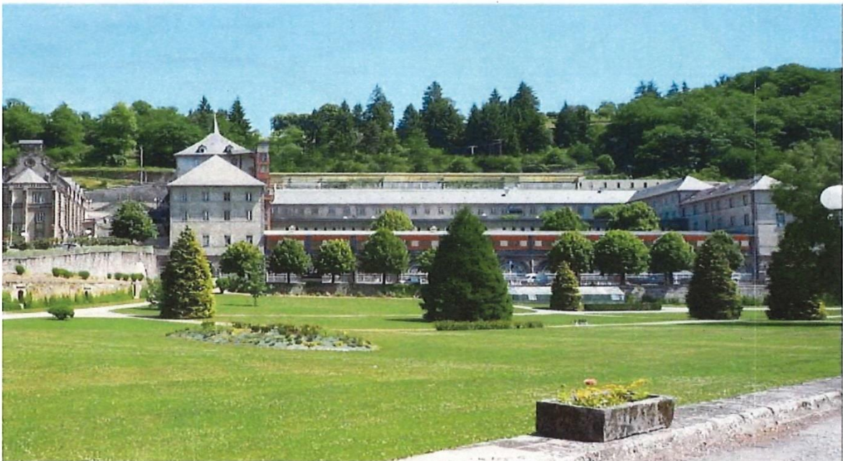
Site de La Celette du Centre Hospitalier du Pays d'Eygurande (CHPE)
