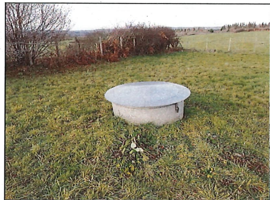
Photo n°6 : Vue de l'absence d'aération au niveau du regard abritant la tête du forage
