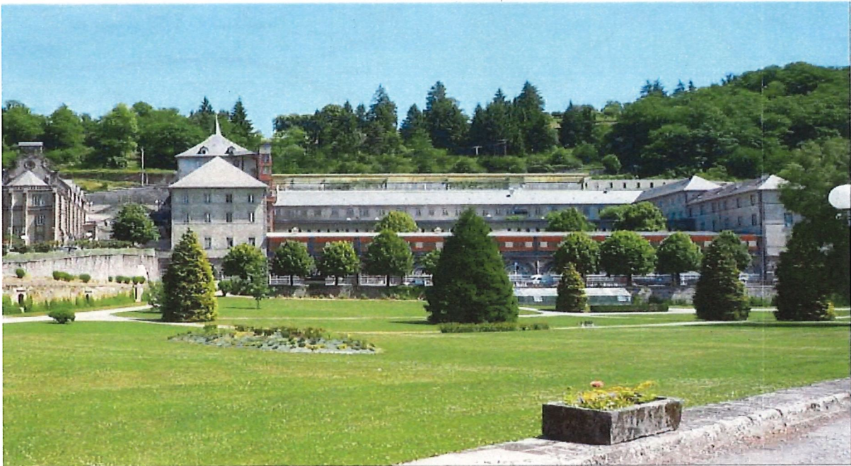
Photo n°1 – Vue du site de La Celette du Centre Hospitalier du Pays d'Eygurande
