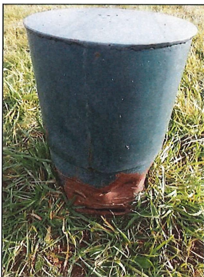
Photo n°7 : Vue de la tête de piézomètre à réhabiliter et à mettre en conformité
