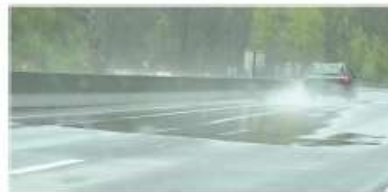
Photo 2 : Accumulation d'eau au PR 25+400
