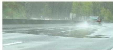
Photo 2 : Accumulation d'eau au PR 25+400
