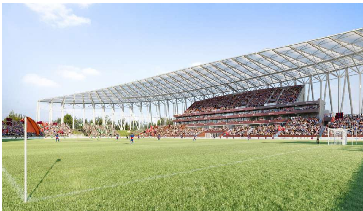
Vue de la nouvelle tribune est depuis l'angle du terrain
