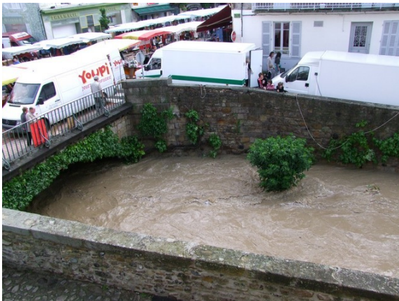
Illustration: Crue de 2012 - Angaud (centre ville près du passage souterrain sous la Poste) – source : Billom Communauté
