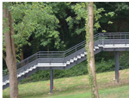
Un escalier léger..
