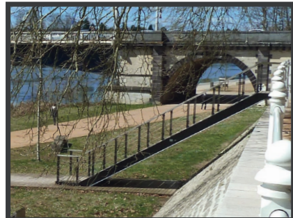
Ouvrages d'art (métal + bois)
