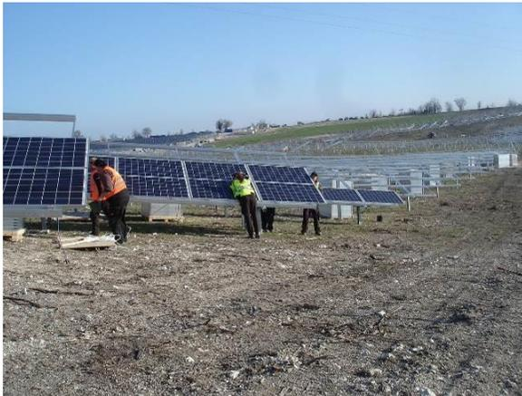
**Photographie 7 - Pose des modules photovoltaïques (source Valeco)**
