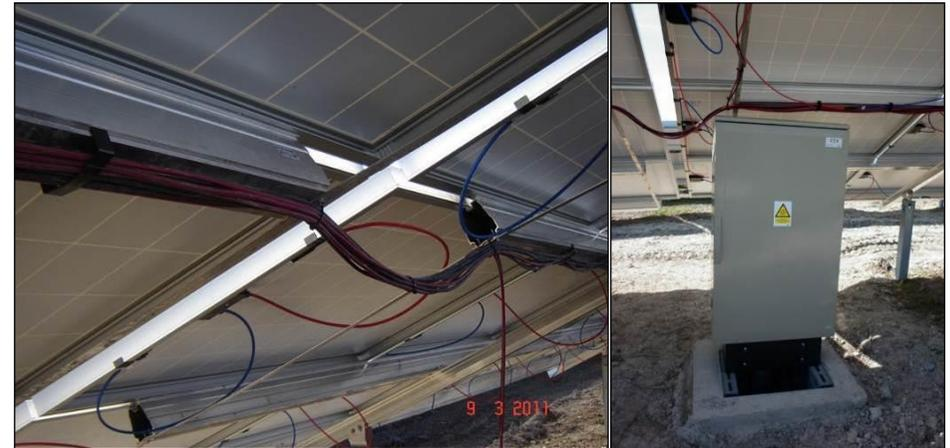
Photographie 3 - Illustration de boîtes de jonction et de raccordement (source Valeco)
