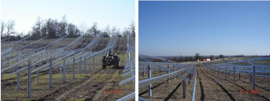
**Photographies 5 et 6 - Fixation des adaptateurs et fixation des rails de supports (source Valeco)**
