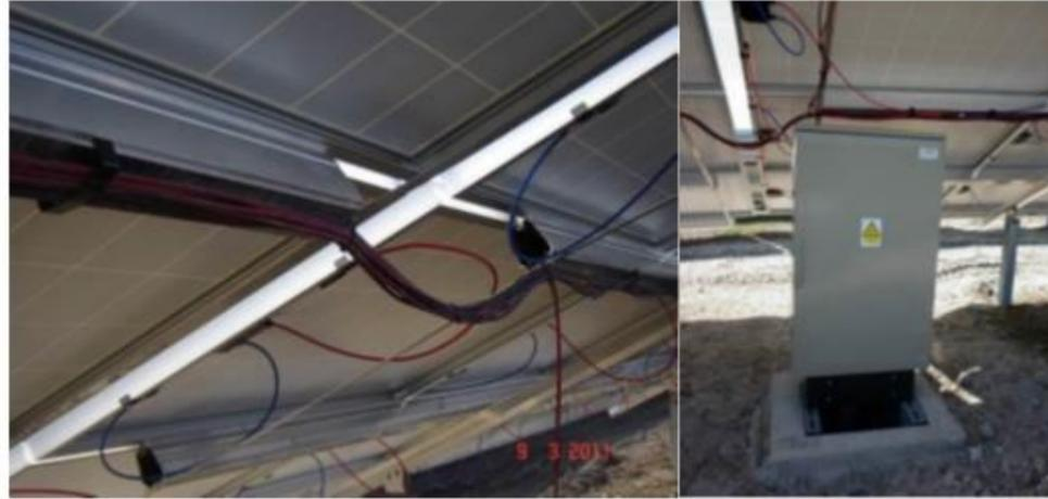
Figure 4 : Illustration du raccordement et d'une boîte de jonction
