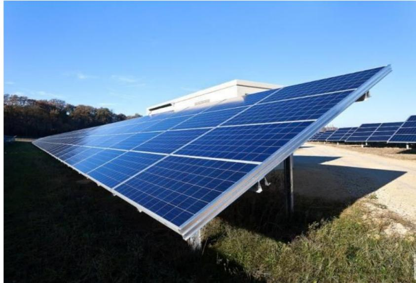
Figure 13 : Photographie d'une table modulaire
