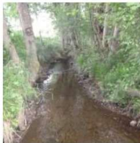
Prise d'eau alimentant le canal d'amenée
