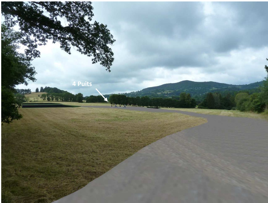
Figure 5 : Vue de l'entrée du site après chantier de forages (4 puits)
