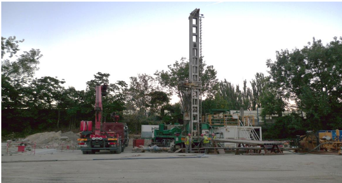
Figure 15 : Photo d'une machine utilisée pour le forage de l'avant trou sur le projet d'Arcueil de type Rig 40 de Itag (2014)
