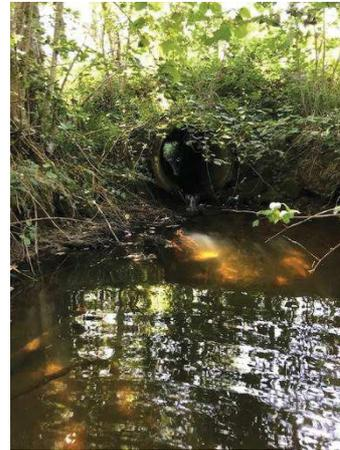
L'objectif ici est double : diminuer la hauteur de chute et augmenter la lame d'eau dans la buse.
