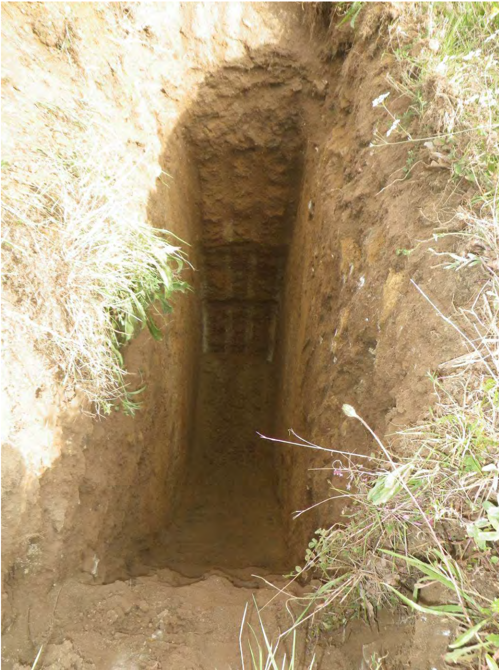
Fond de fouille
