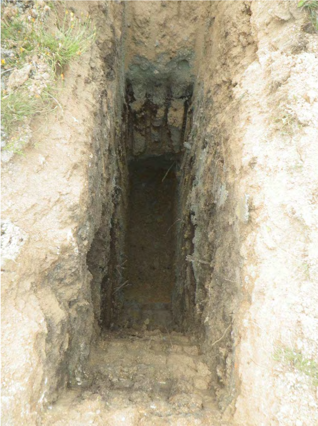
Fond de fouille
