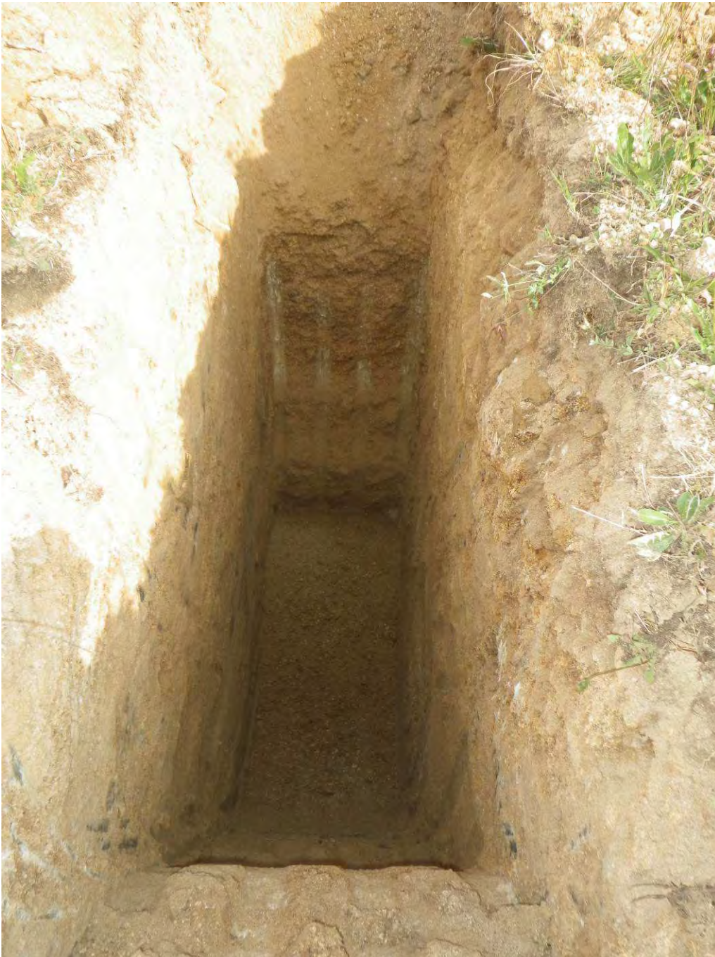
Fond de fouille
