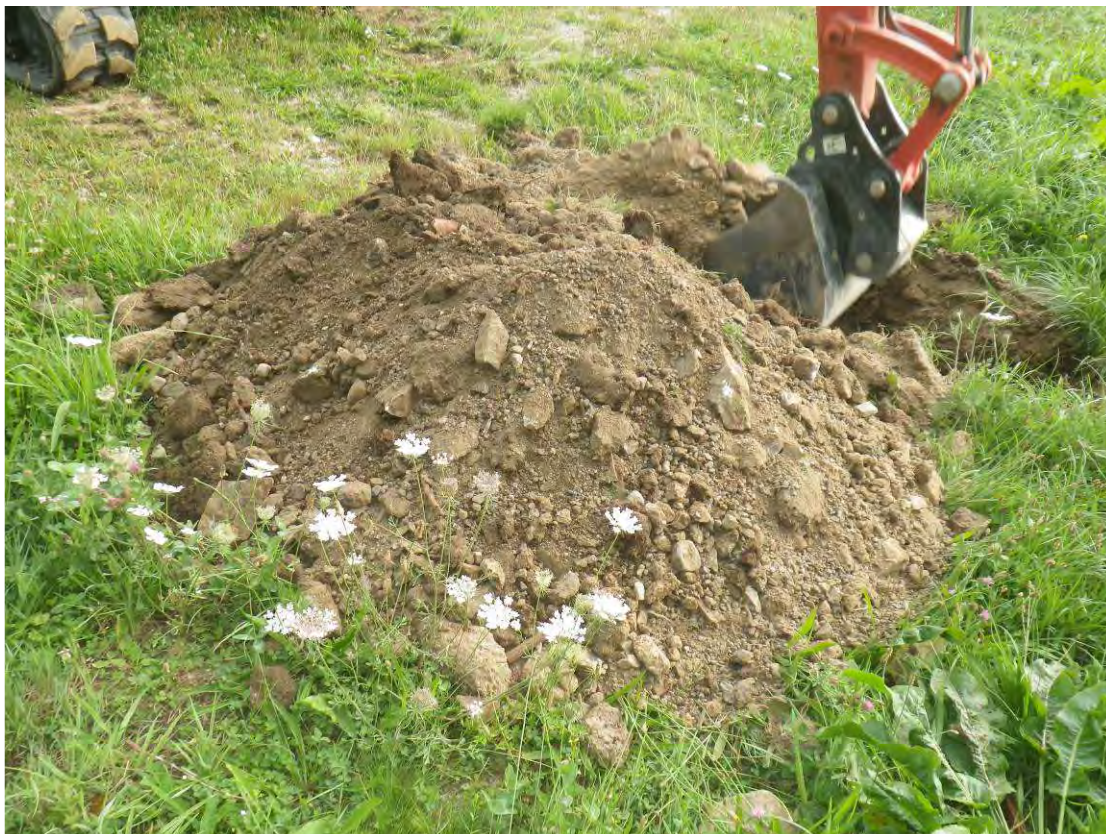
Remblai sablo-graveleux beige avec béton, bois, plastique et blocs
