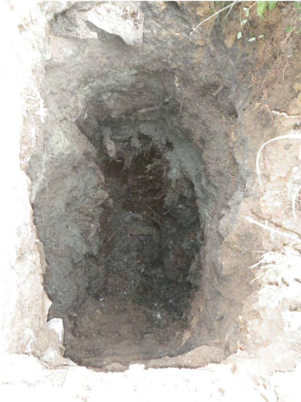
Fond de fouille
