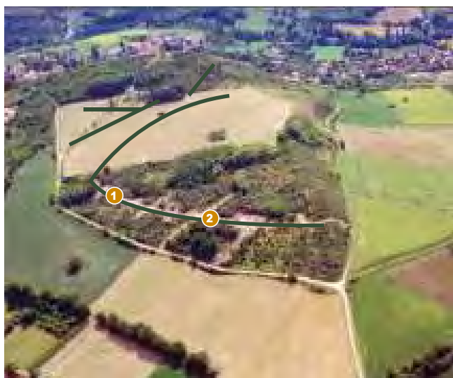
Figure 47. Opération de fouille réalisée sur le flanc septentrional en 1996 (V. Guichard).
