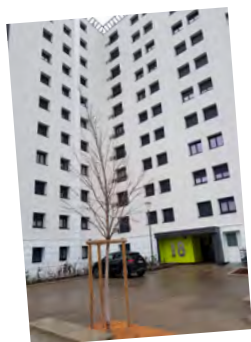
Réhabilitation à Clermont-Fd (Logidôme)
