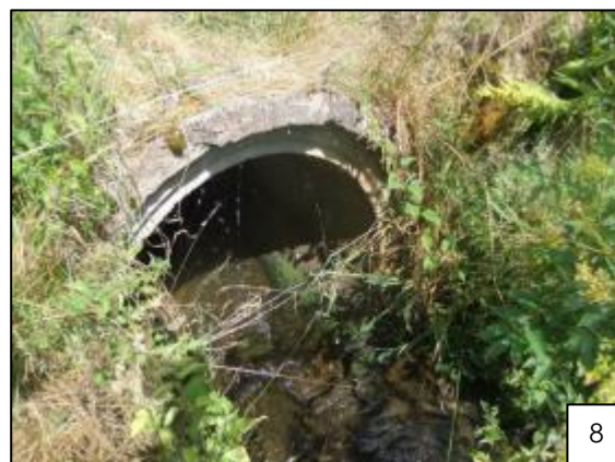
Franchissement sous la route
