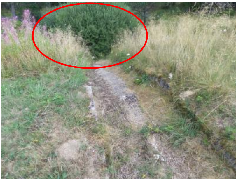
Figure 19 : coursier de l'évacuateur de crues
