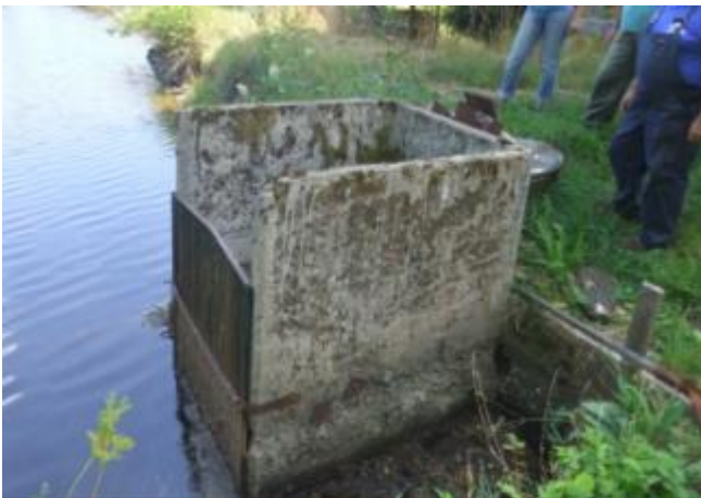
Figure 7 : Moine du plan d'eau de la scierie
