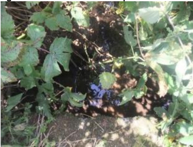
Figure 9 : Exutoire amont de la partie busée n°2
