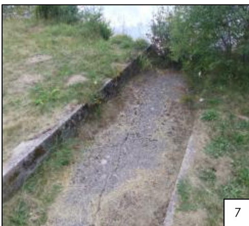
Evacuateur de crue
