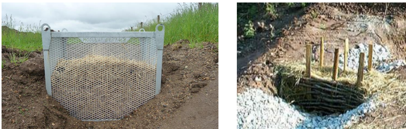
Figure 30 : Exemples de filtre à paille
