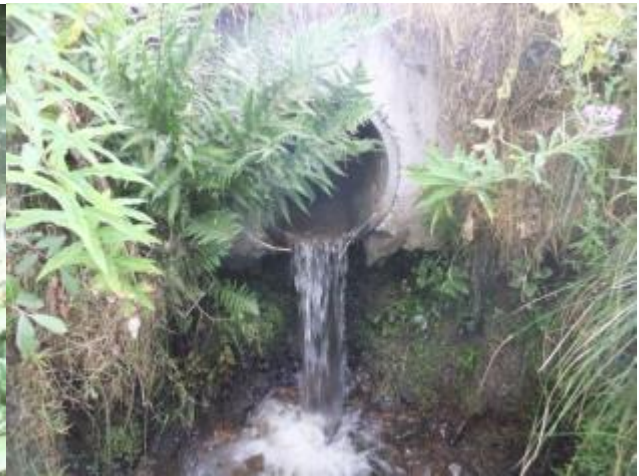
Figure 10 : Exutoire aval de la partie busée n°2
