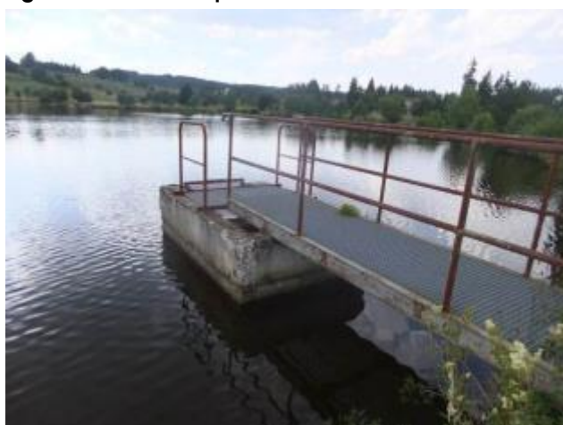
Figure 20 : moine et passerelle
