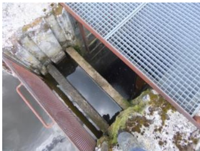
Figure 21 : bastaings et grille métallique
