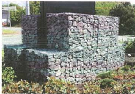
Figure 18 : Exemple de muret en gabion
