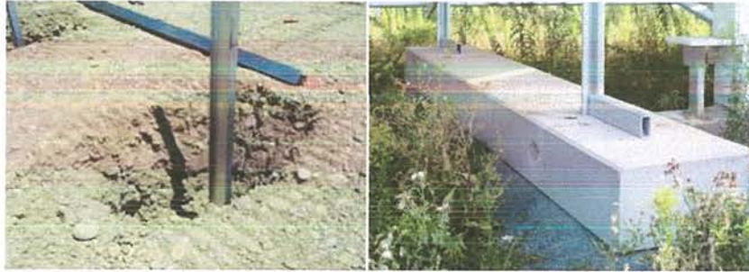
Figure 16 et 17 : Types de fondation - pieux battus (gauche) et semelle béton (droite)
