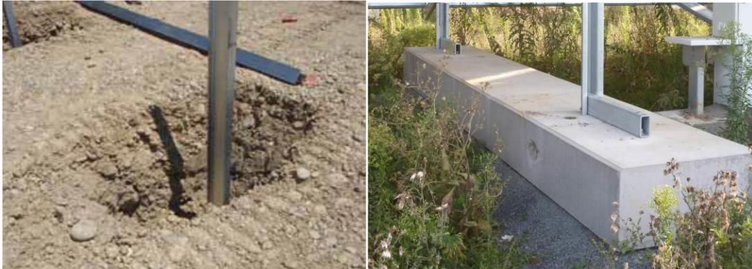
Figure 15 et 16 : Types de fondation - pieux battus (gauche) et semelle béton (droite)
