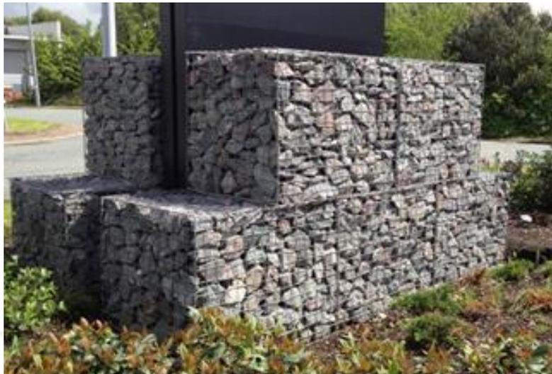
Figure 17 : Exemple de muret en gabion
