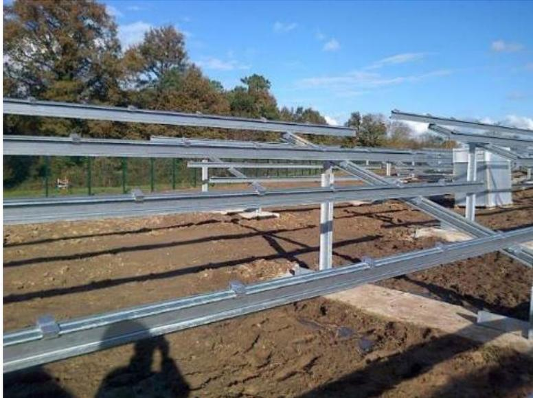
Figure 13 : Exemple de chantier de construction – pose de structures (Crédit photo : SERGIES, 2015)
