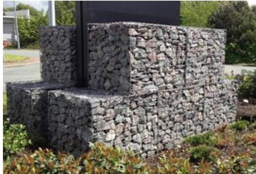
Figure 18 : Exemple de muret en gabion
