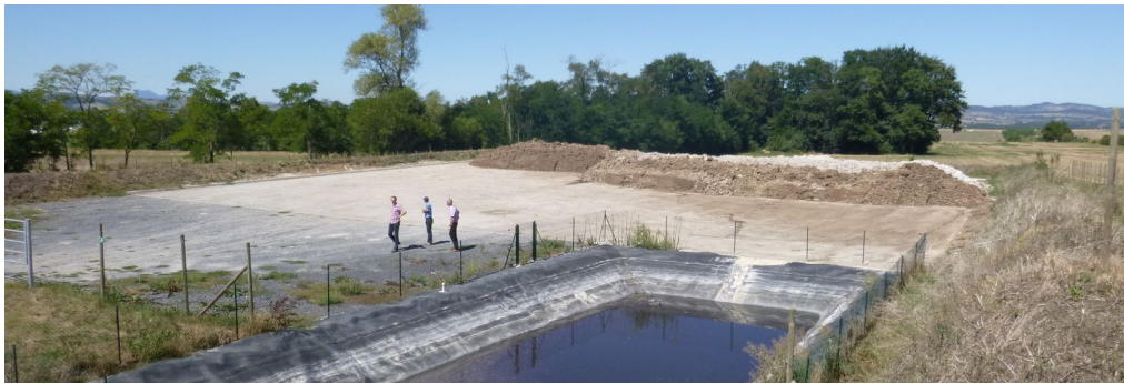
Plate-forme de stockage des boues de Clermont Métropole à Saint-Martin des plains – août 2017
