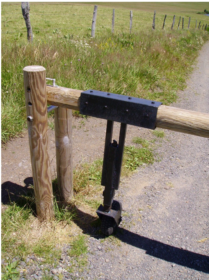
Barrière équipée d'une roue pour en faciliter l'ouverture et passage piéton juste à côté (à gauche)
