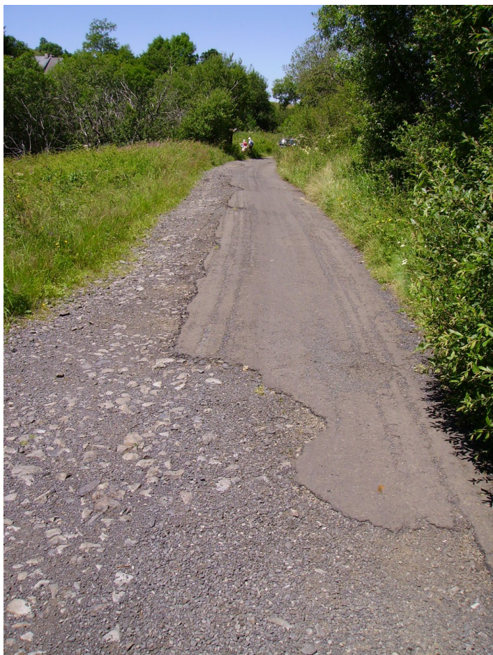
Des secteurs dégradés (la couche superficielle de goudron et l'empierrement affleurant sont visibles)
