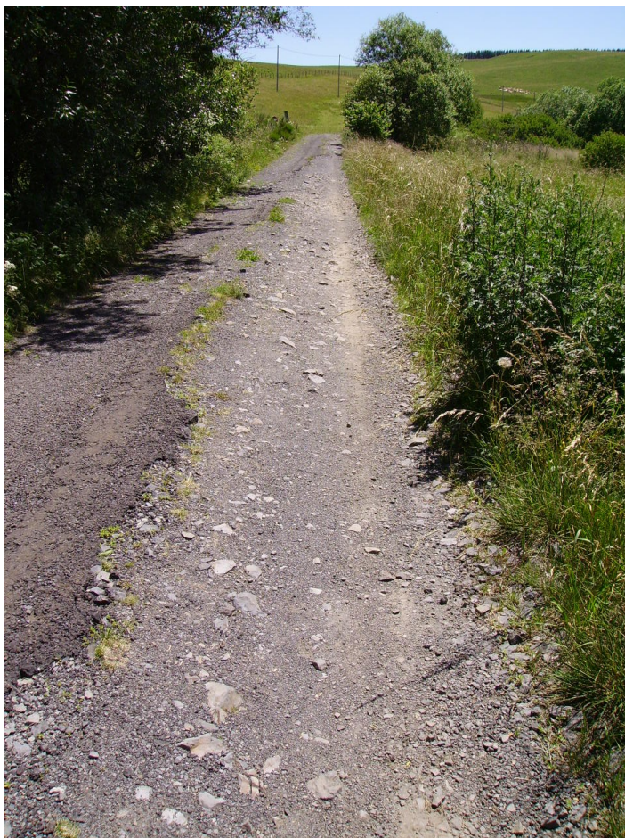
Des secteurs dégradés (la couche superficielle de goudron et l'empierrement affleurant sont visibles)
