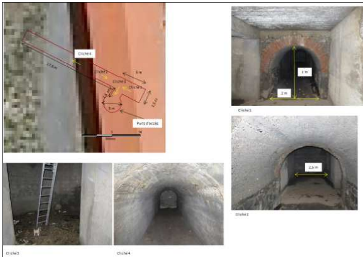
Figure 17 : Clichés de l'intérieur de la poudrière - Mesures de gabarit
