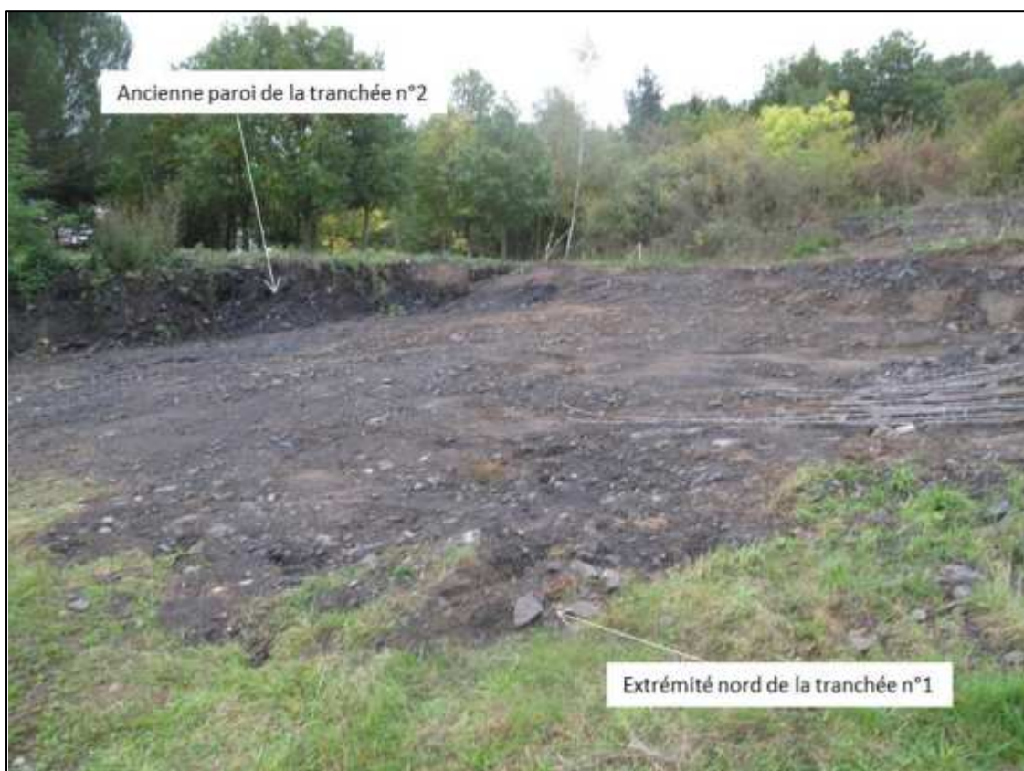
Figure 7 : Vue générale de la zone décapée
