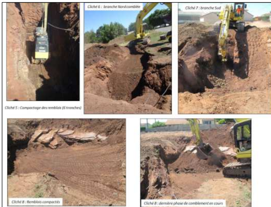
Figure 15 : Remblayage et compactage
