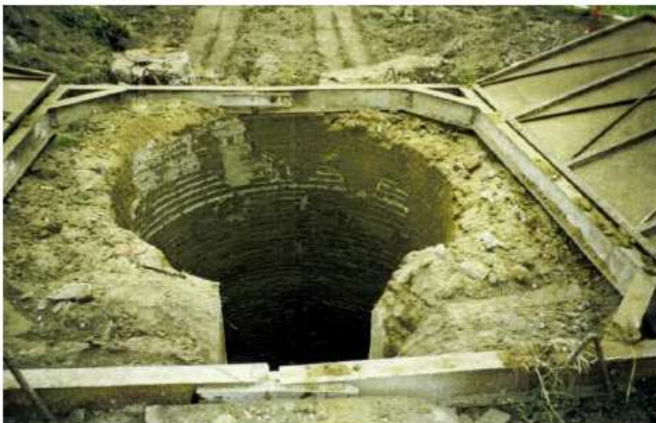
Photo 120 : Puits de Chamblève avant travaux
