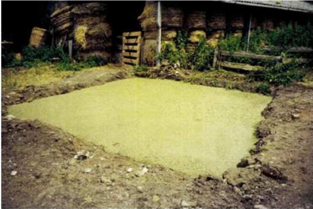
Photo 101 : Dalle en béton armé du puits du Feu
