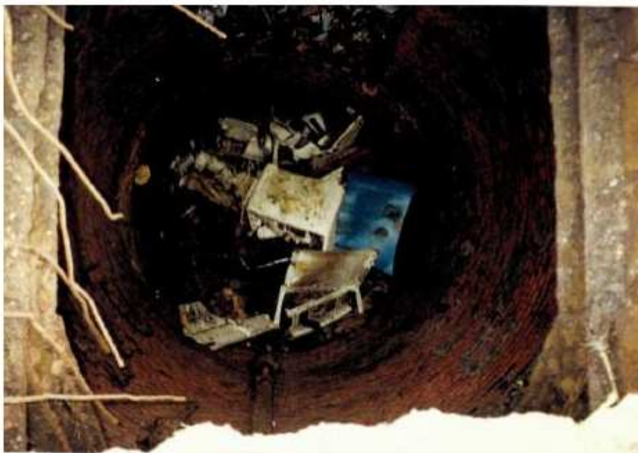
Photo 102 : Puits de l'Ouest avant travaux
