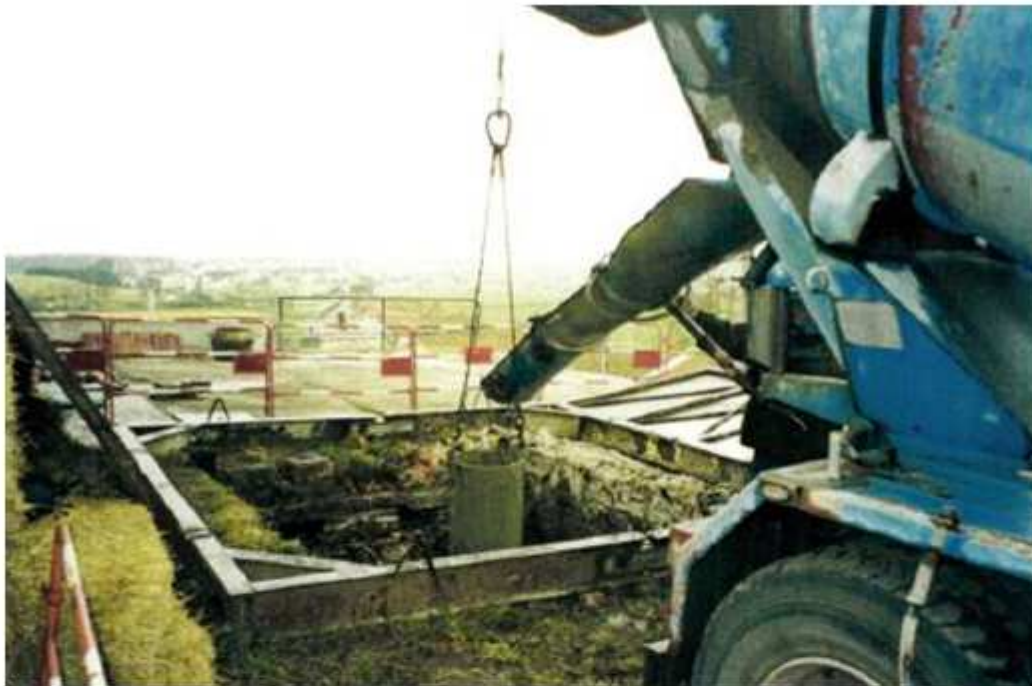
Photo 125 : Coulage du bouchon béton au puits de Coincy
