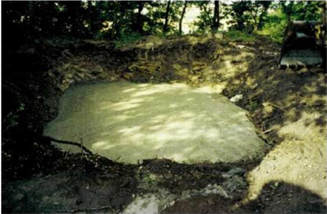
Photo 133 : Dalle de béton à l'aplomb du puits de Tinderelle
