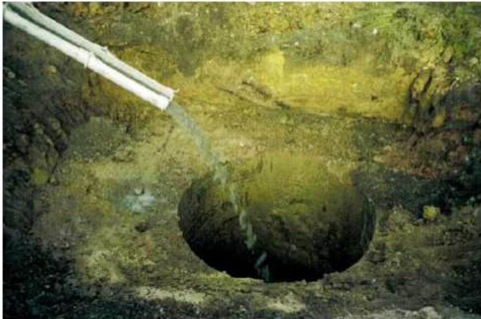
Photo 122 : Coulage du bouchon béton au puits de Chamblève
