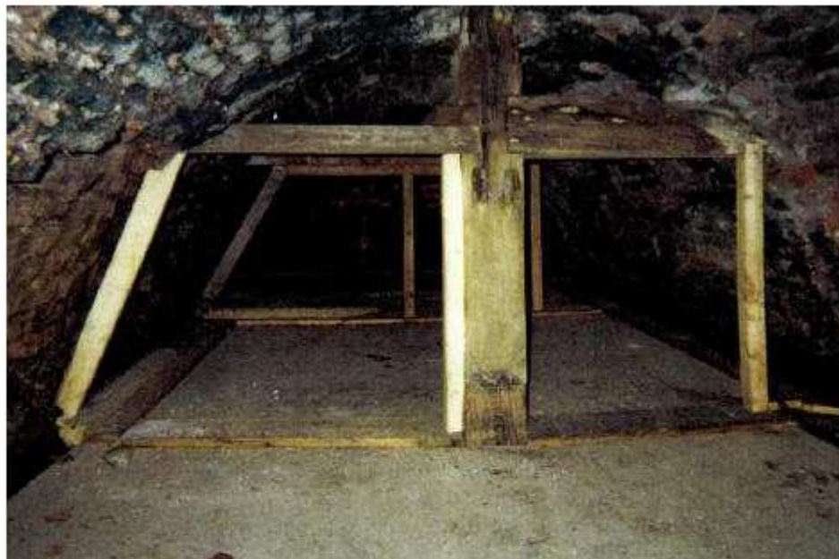
Photo 108 : Plancher de bois sur gravier
