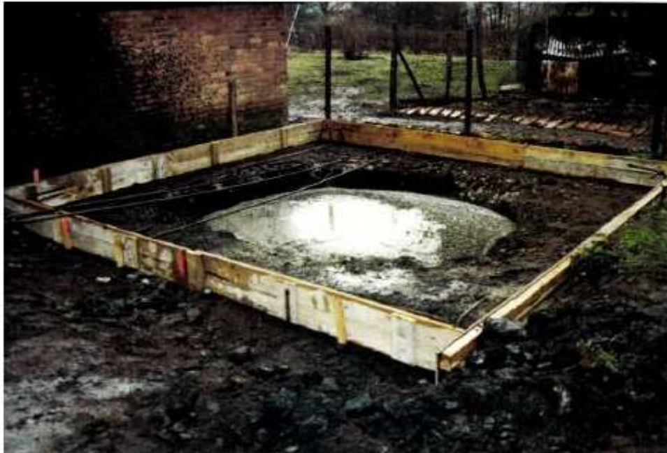
Photo 98 : Coulage du bouchon béton du puits Morny
