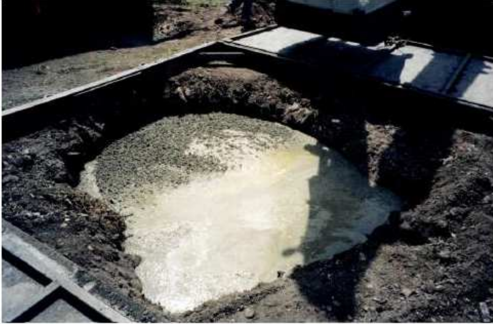
Photo 69 : Coulage du bouchon béton du puits de La Machine
