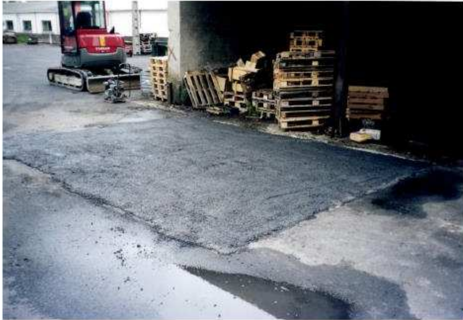
Photo 59 : Site de l'aérage du petit puits de Cellamines après travaux
