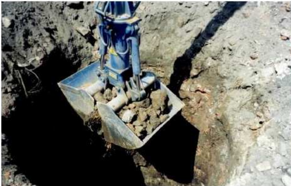
Photo 52 : Curage du puits de Basse-Combelle
