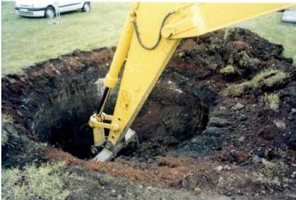
Photo 65 : Curage du puits Saint-Alexandre
