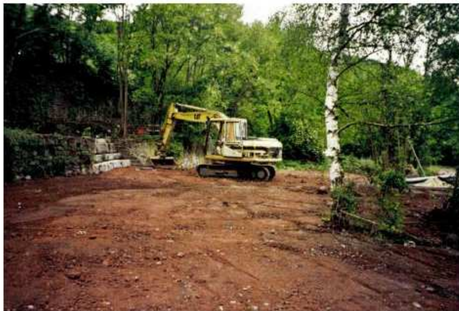
Photo 112 : Remise en état après travaux du site de la galerie du Rouge
