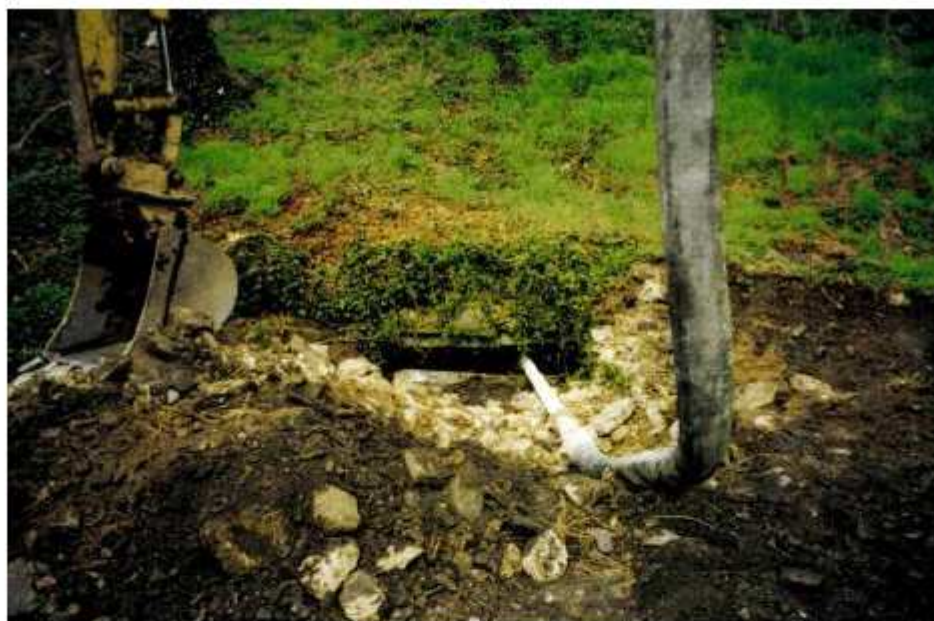
Photo 86 : Coulage du béton dans la galerie Denières
