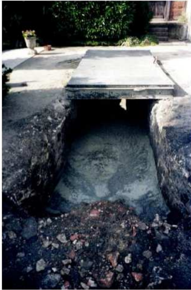
Photo 56 : coulage du bouchon béton du puits de la Verrerie
