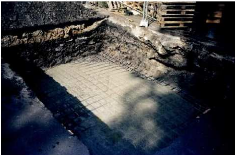
Photo 58 : Coulage de la dalle de l'aéragé du petit puits de Cellamines
