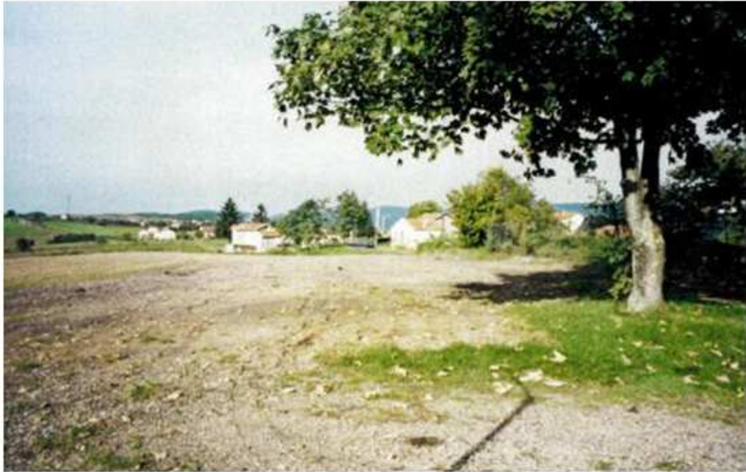
Photo 119 : Site du puits du Président après travaux
