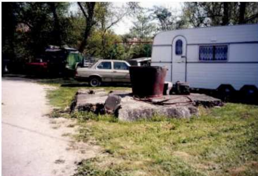
Photo 72 : Puits Sud avant travaux
