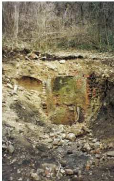
Photo 91 : Puits des Echelles avant travaux
