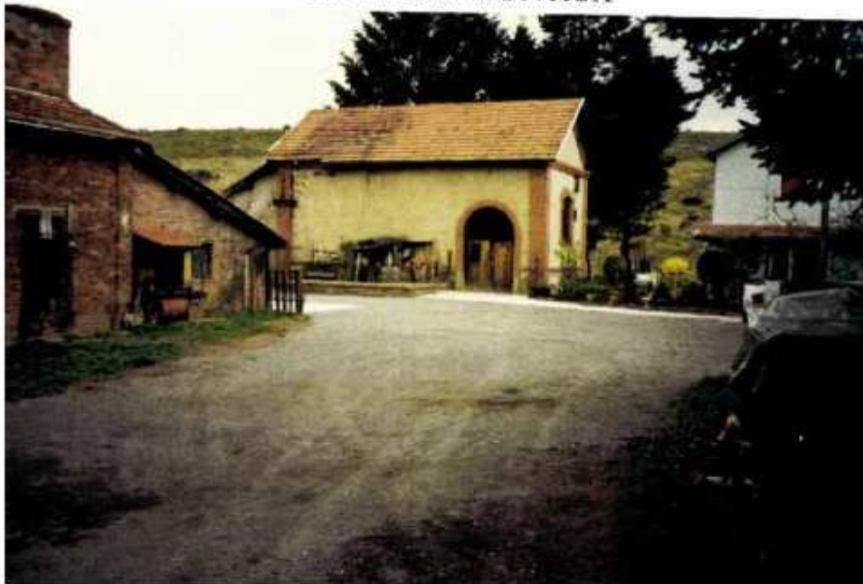
Photo 99 : Site du puits Morny après travaux
