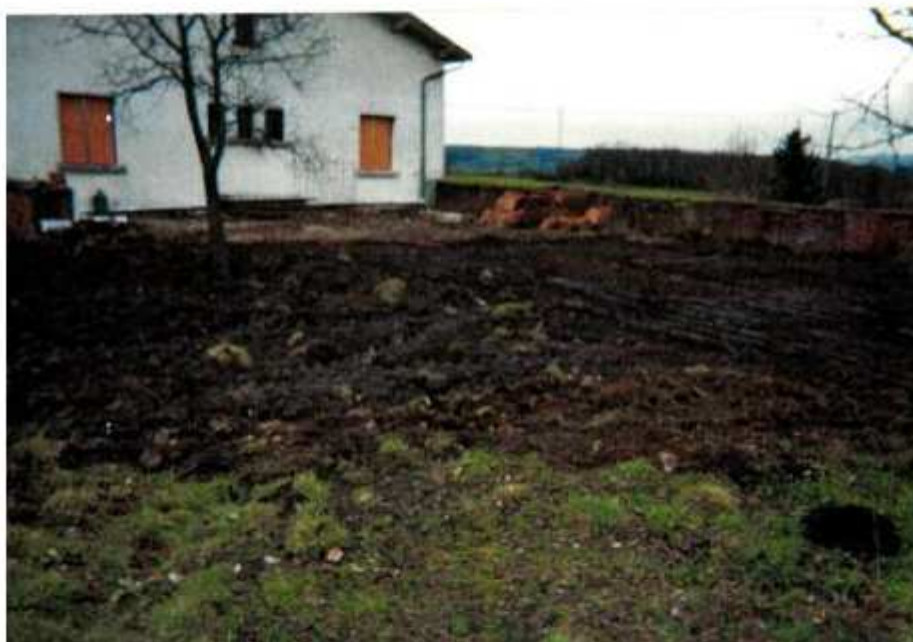
Photo 106 : Site du puits de l'Ouest après travaux
