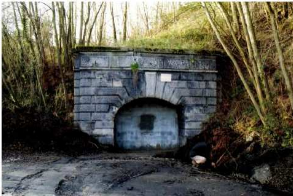
Photo 64 : Entrée du tunnel du puits des Graves après travaux
