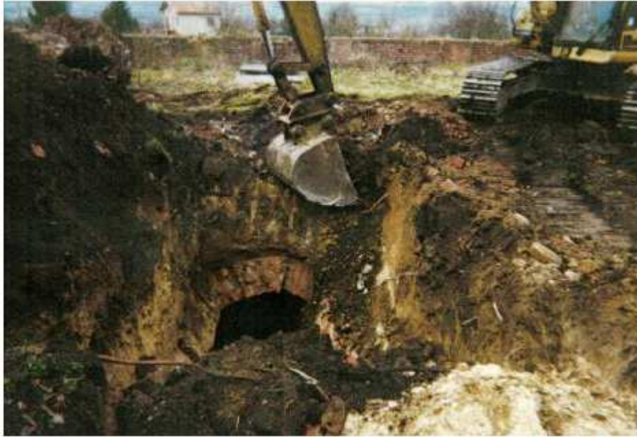
Photo 103 : Démolition de la galerie d'aéragé
