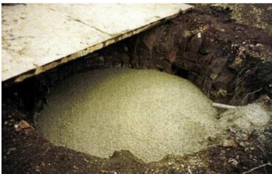
Photo 89 : coulage du bouchon béton du puits Denières
