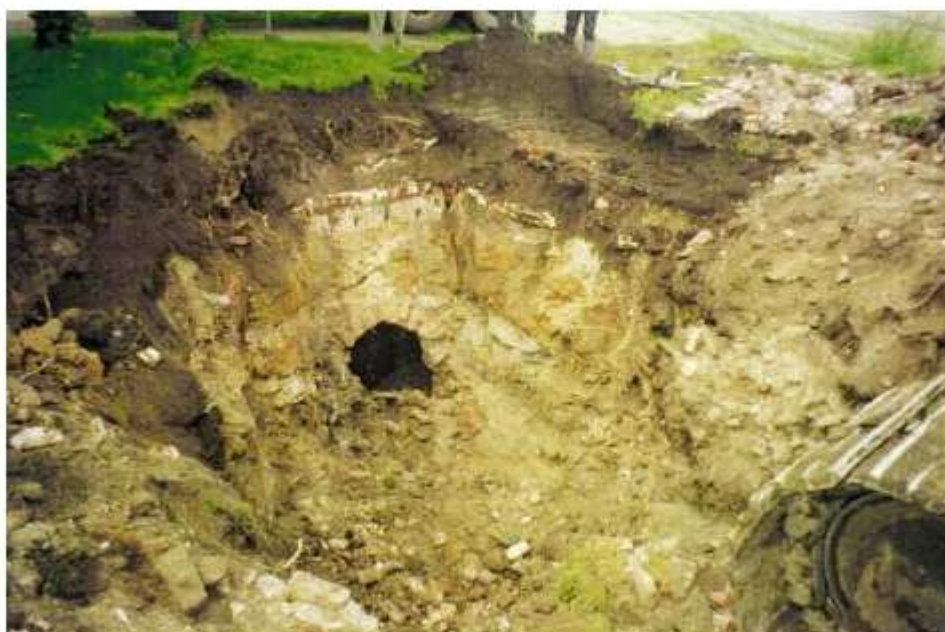
Photo 117 : Galerie d'accès au puits du Président
