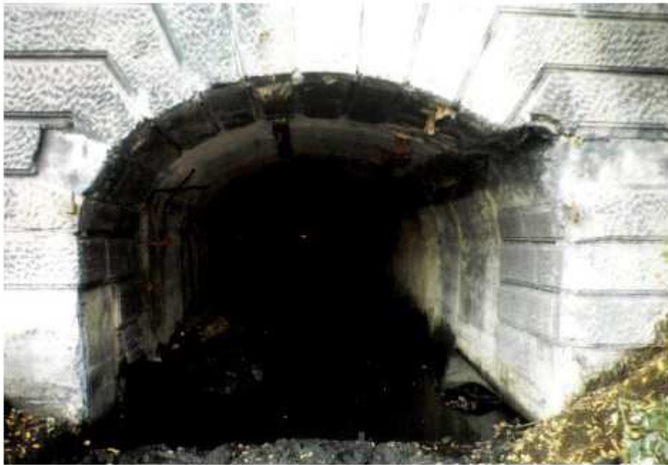
Photo 61 : Tunnel du puits des Graves avant travaux
