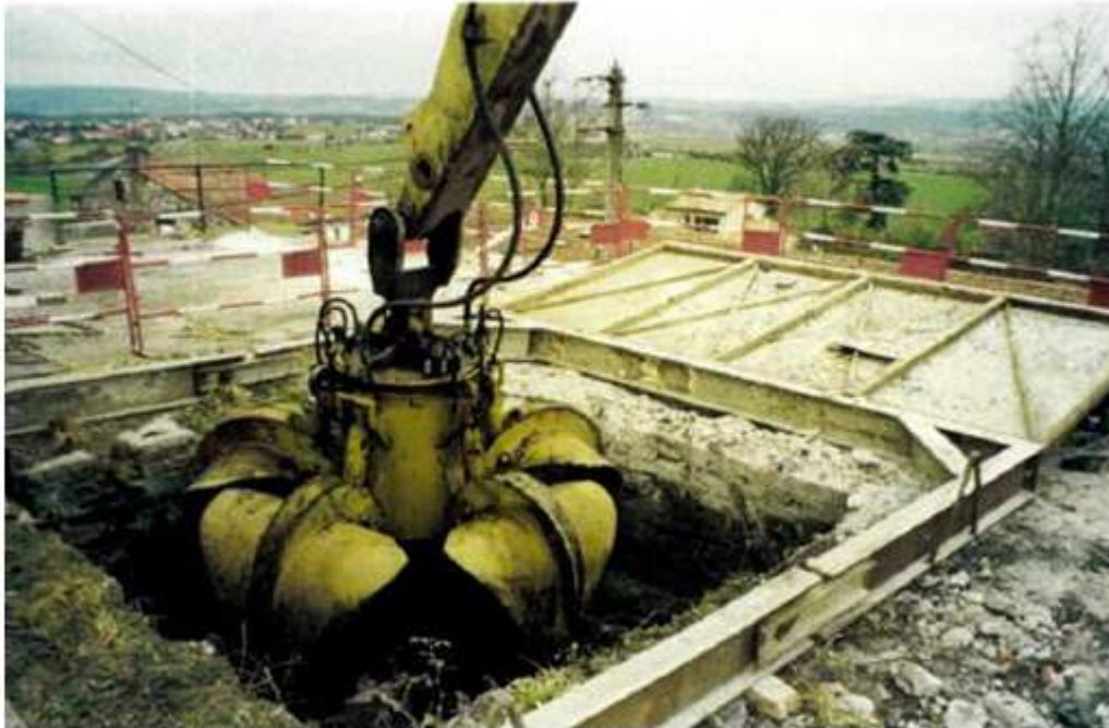
Photo 124 : Décaissement du puits de Coincy
