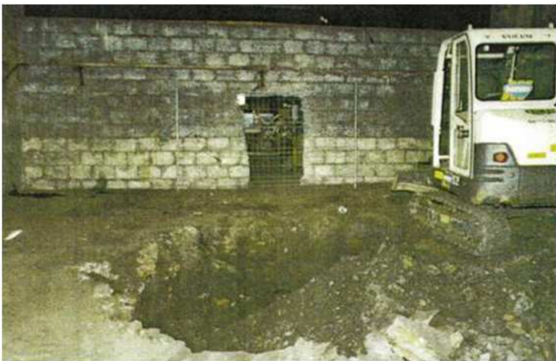
Photo 137 : Puits de Grosménil avant travaux
