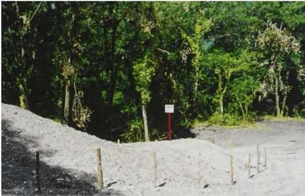
Photo 141 : Puits des Echelles après travaux
