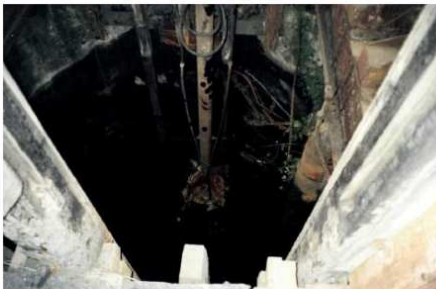
Photo 48 : Curage du puits des Graves
