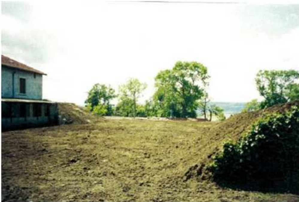
Photo 127 : Site du puits de Coincy après travaux
