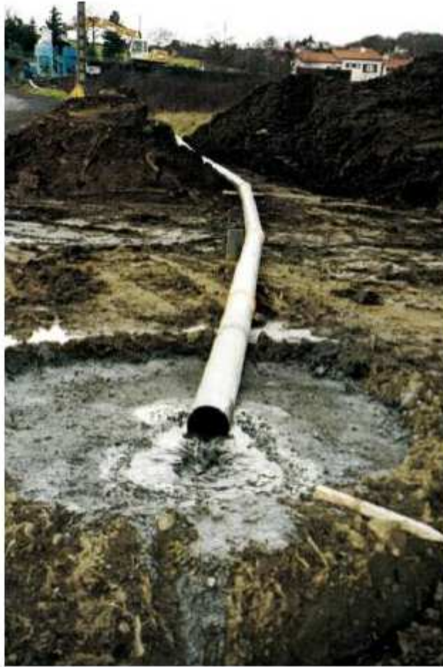
Photo 81 : Embouage du tunnel de Fondary (vue extérieure)
