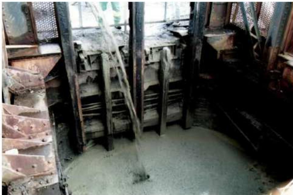
Photo 50 : Coulage du bouchon béton du puits Bayard
