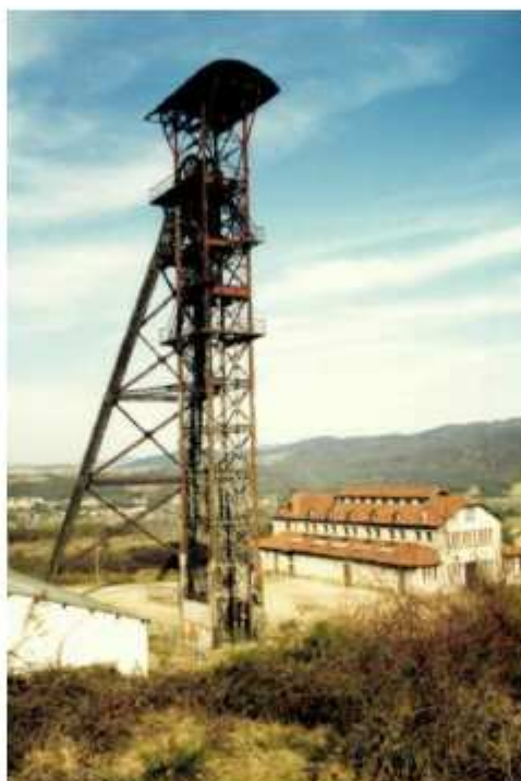
Photo 47 : Puits des Graves avant travaux
