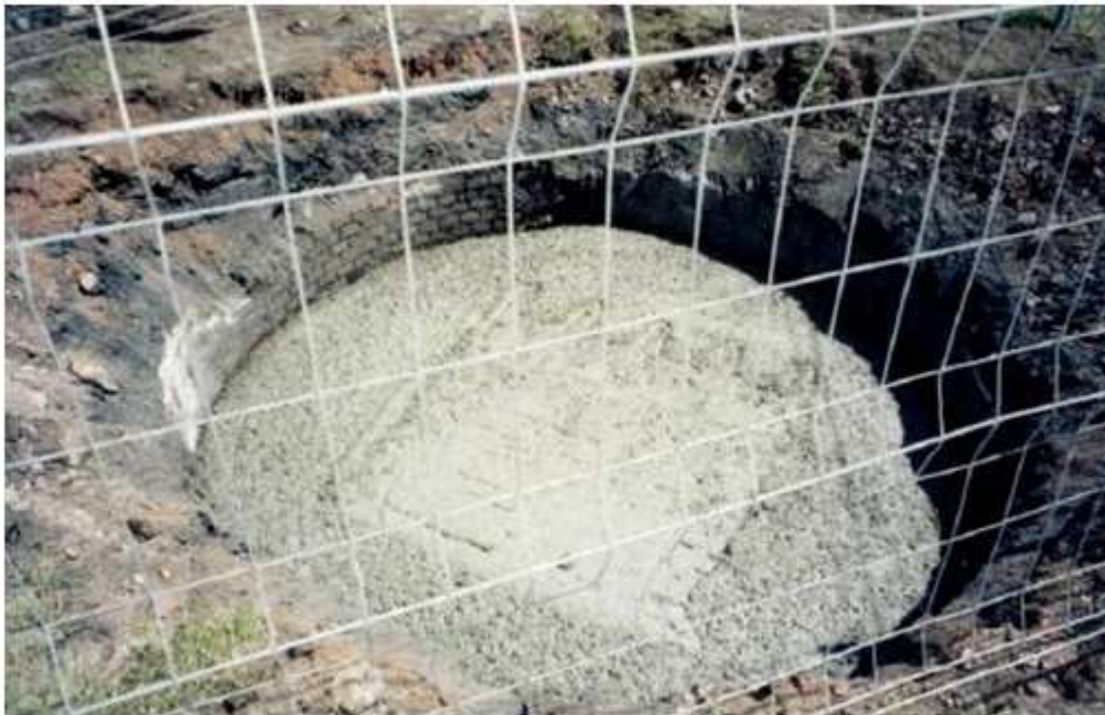
Photo 66 : Mise en place du bouchon béton du puits Saint-Alexandre
