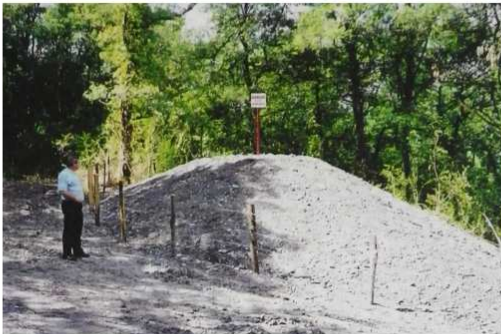
Photo 142 : Puits Sabatier après travaux
