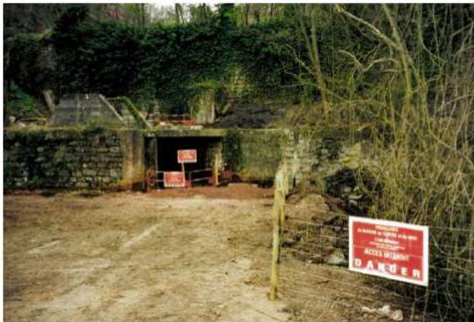
Photo 107 : Galerie du Rouge avant travaux
