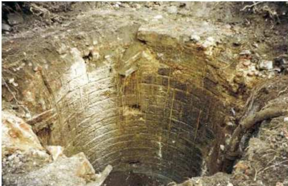
Photo 88 : Puits Denières avant travaux
