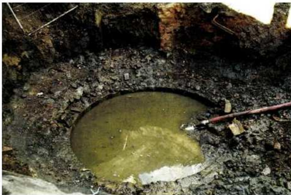
Photo 77 : Orifice du puits d'aération n°2
