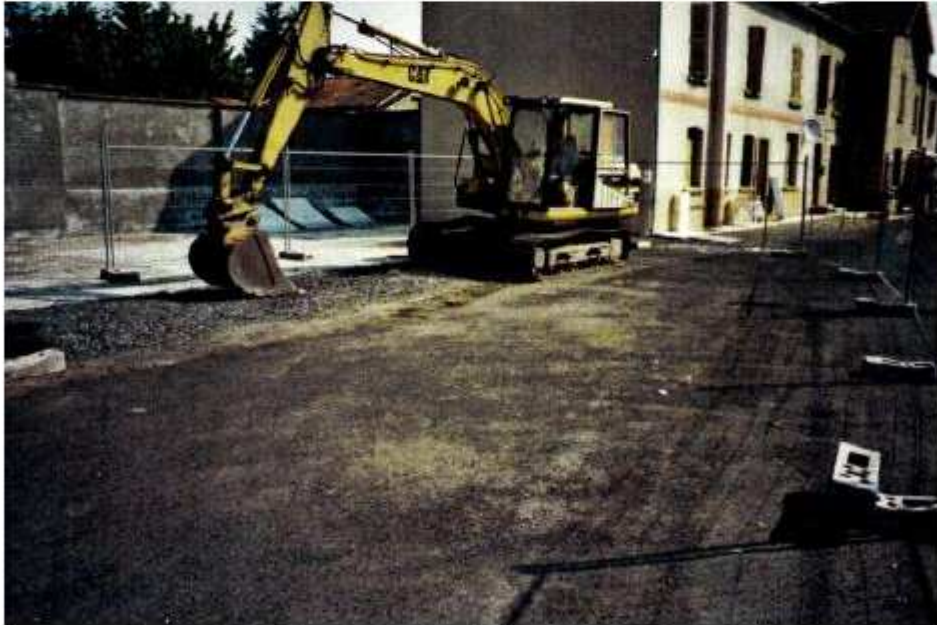
Photo 84 : Site du puits de La Forge après travaux
