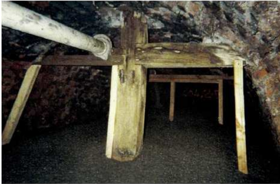
Photo 109 : Bétonnage de la galerie du Rouge
