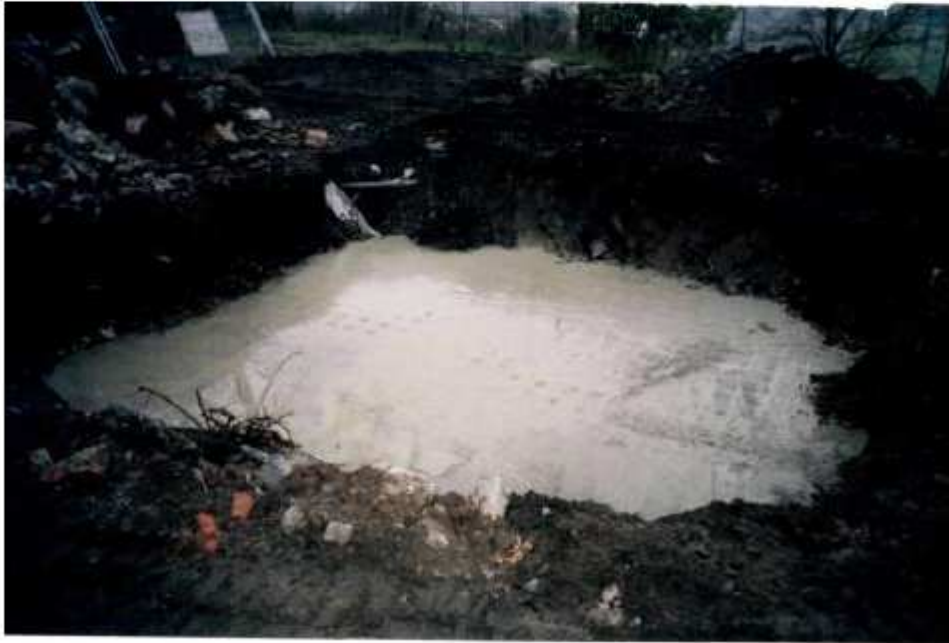
Photo 73 : Coulage de la dalle en béton armé du puits Sud
