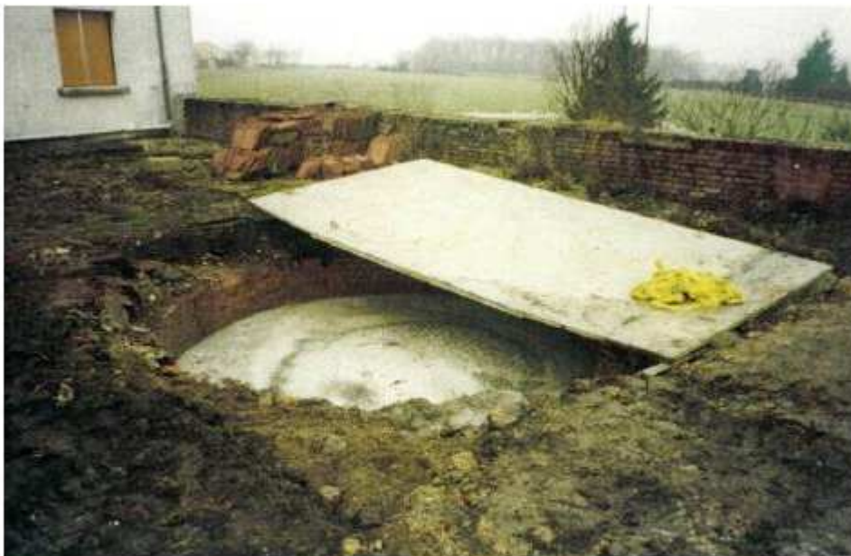
Photo 105 : Bouchon béton du puits de l'Ouest
