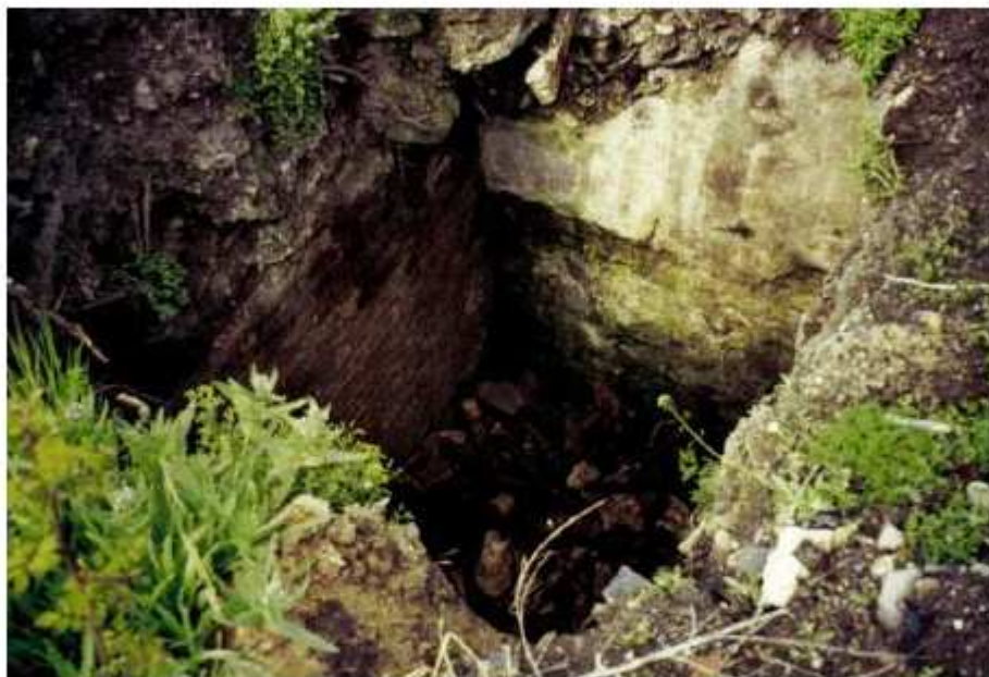
Photo 128 : Puits de la Cloche avant travaux
