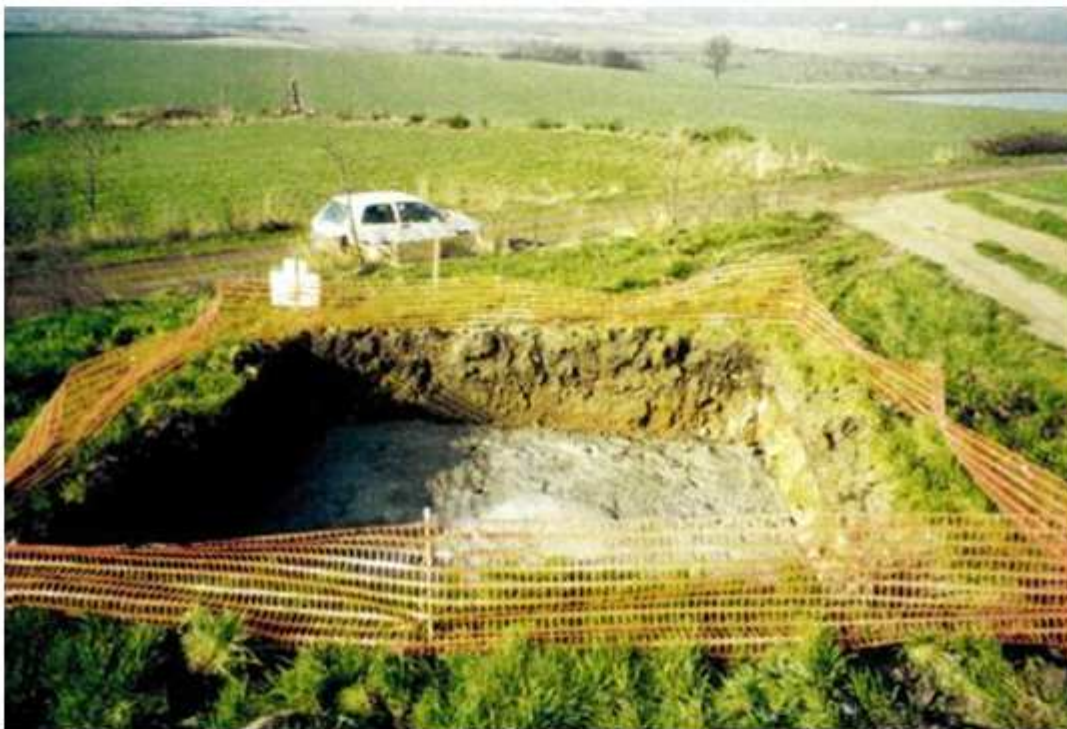
Photo 131 : Dalle de béton armé à l'aplomb du puits de la Pompe
