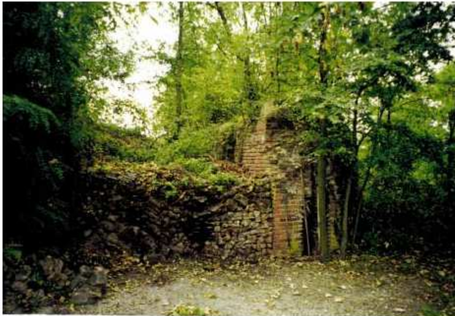
Photo 123 : Site du puits de Coincy avant travaux
