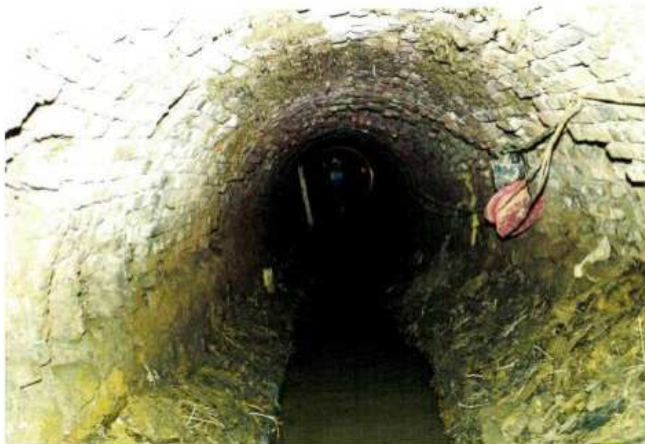
Photo 79 : Tunnel de Fondary avant travaux
