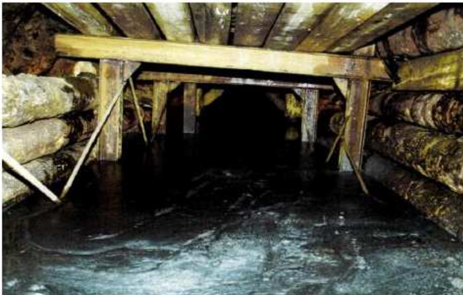
Photo 82 : Embouage du tunnel de Fondary (vue intérieure)
