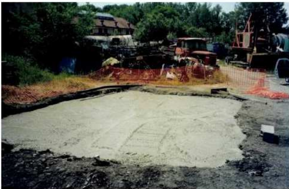
Photo 54 : Mise en place de la dalle béton du puits de Basse-Combelle
