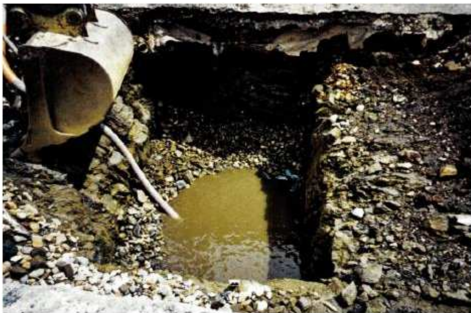
Photo 83 : Puits de la Forge au rocher
