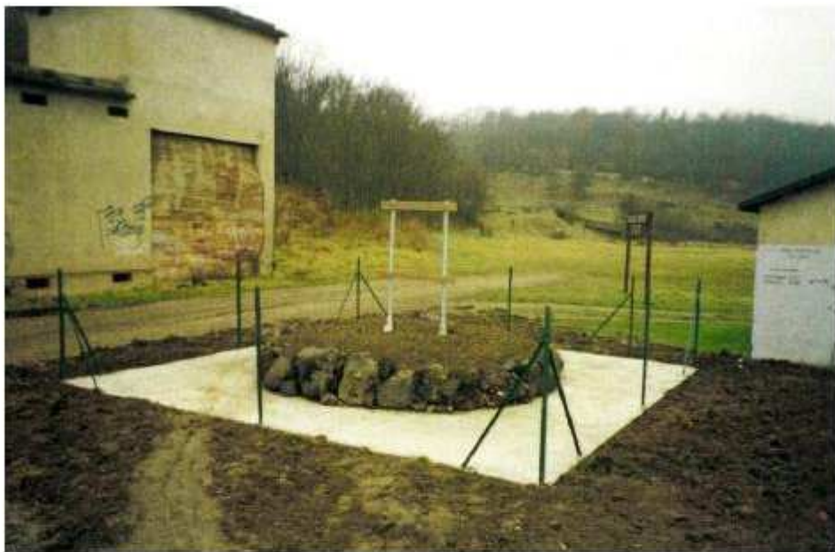
Photo 96 : Puits du Parc après travaux
