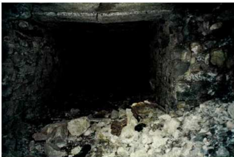
Photo 85 : Etat de la galerie Denières avant travaux
