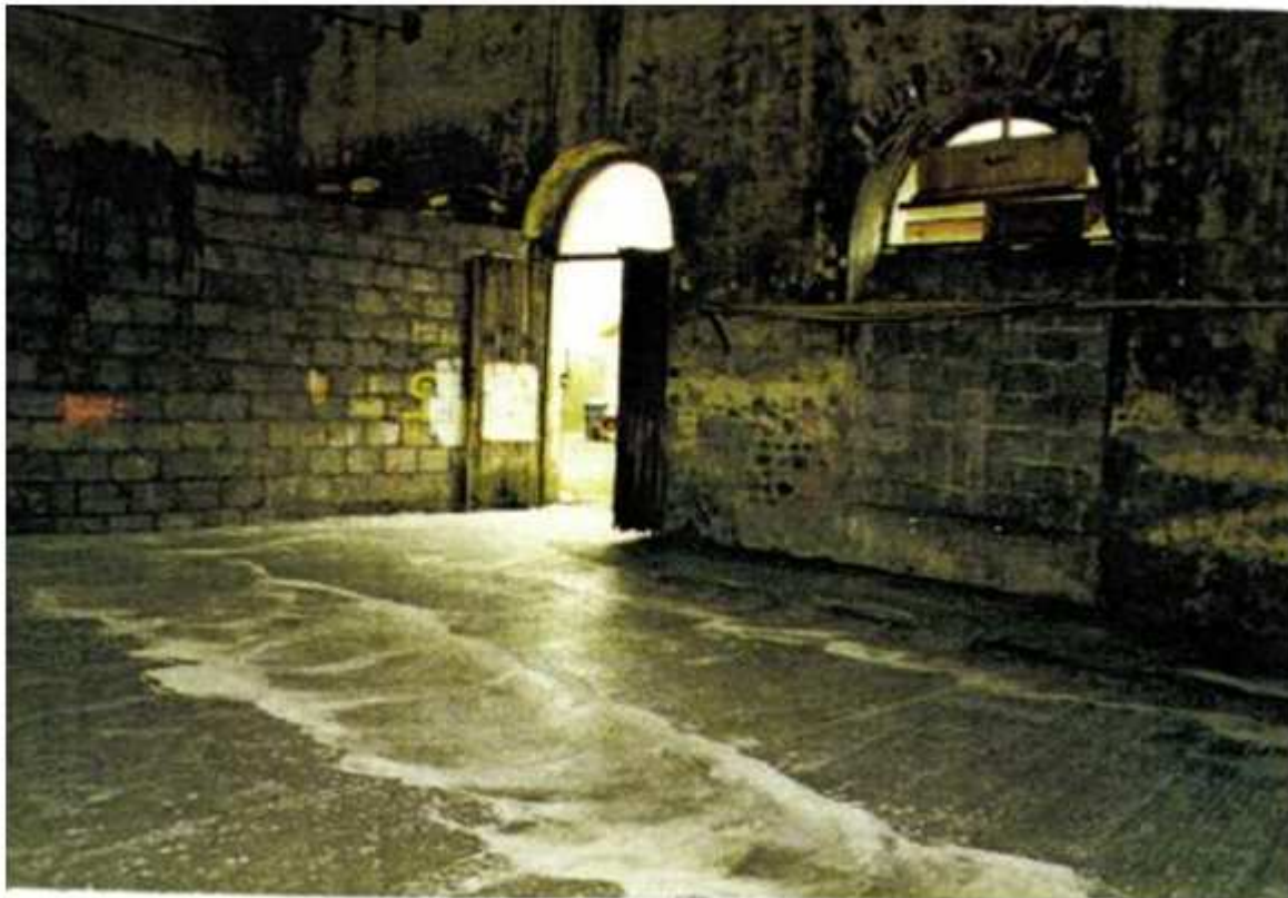
Photo 140 : Puits de Grosménil après travaux
