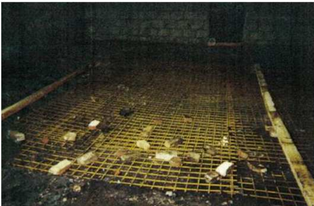
Photo 139 : Dalle de couverture située à l'aplomb du puits de Grosménil
