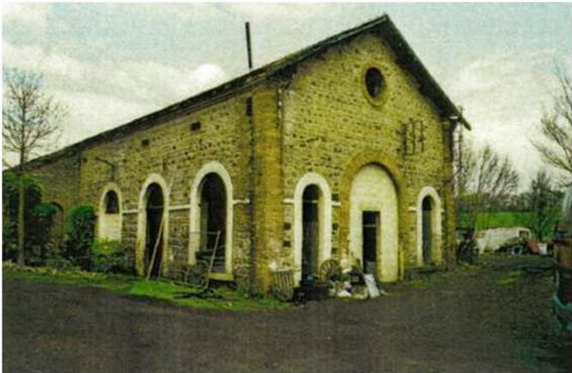
Photo 136 : Site du puits de Grosménil avant travaux
