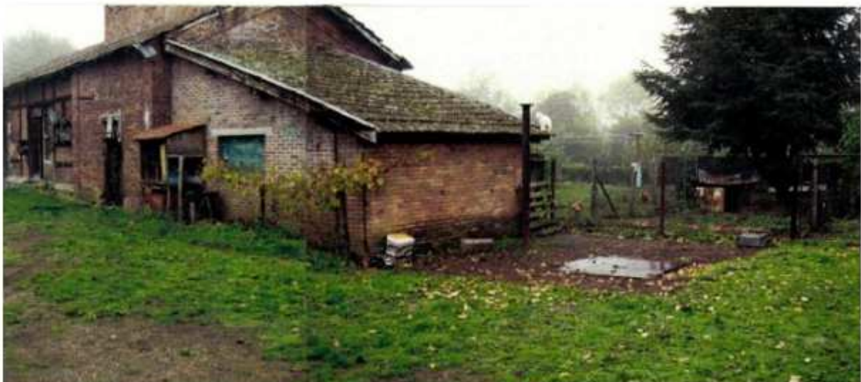
Photo 97 : Puits Morny avant travaux
