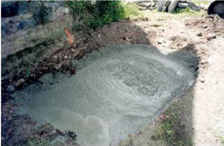
Photo 71 : Remblayage en béton de la galerie d'aérage 2
