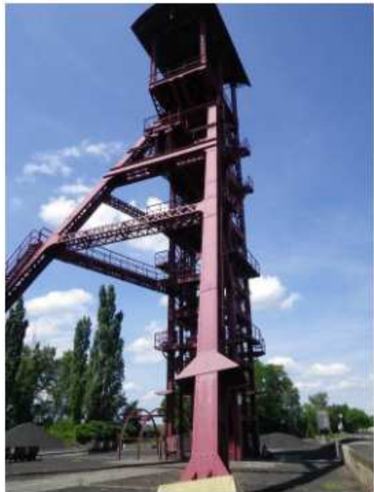
Photo 38 : Puits Bayard (P3) - Combelle
