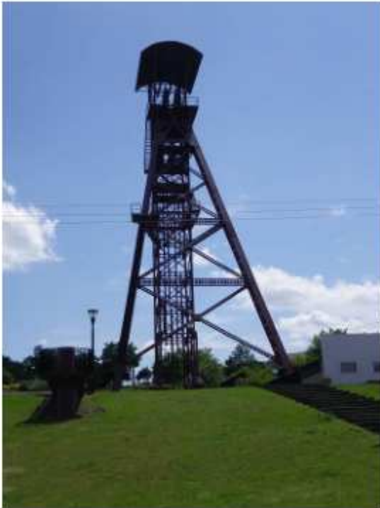
Photo 39 : Puits des Graves (P9) - Combelle
