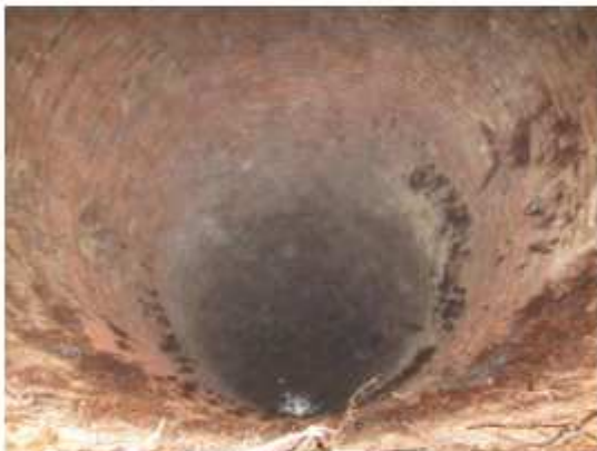
Photo 46 : Vue de l'intérieure du puits de Frugères
