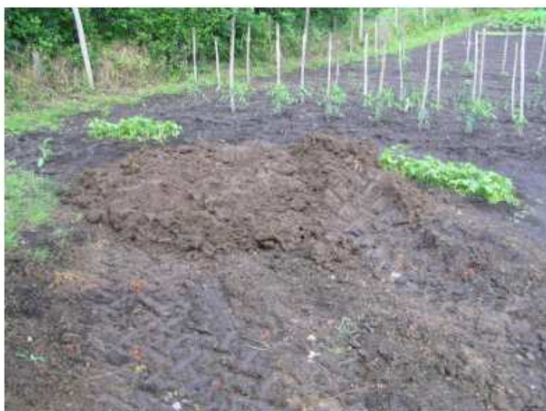
Photo 11 : Remblayage du fontis D10
