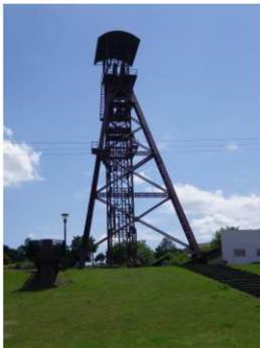
Photo 20 : Chevalement du Puits des Graves
