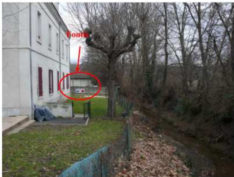
Photo 4 : Localisation du fontis d'Arrest (Source : GEODERIS, 2008)
