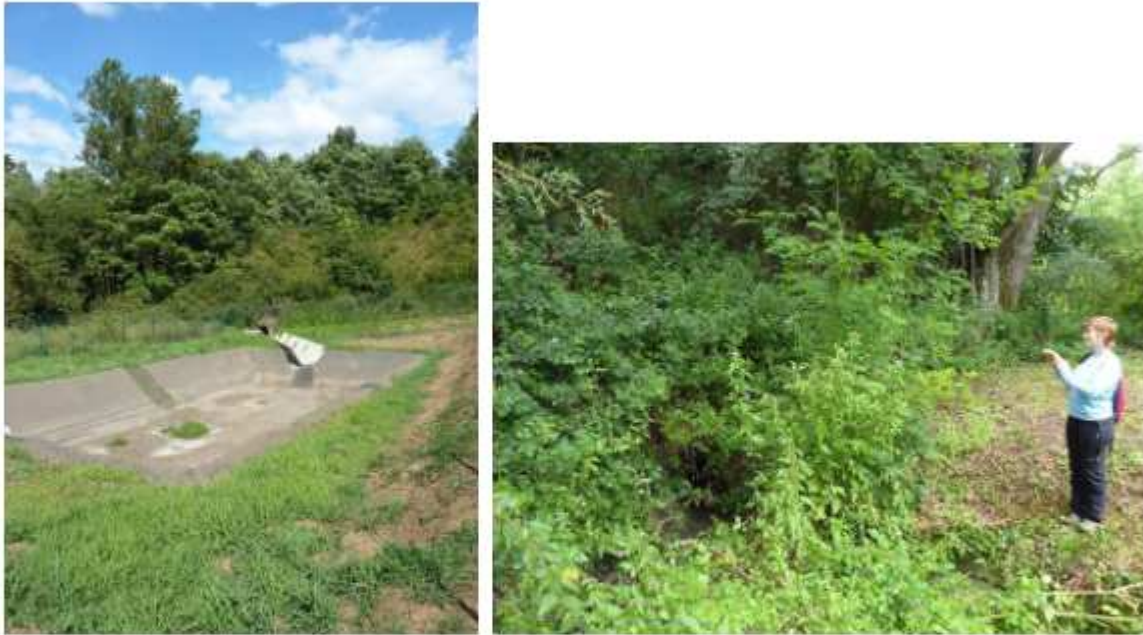
Photo 23 : Extrémités de la buse
