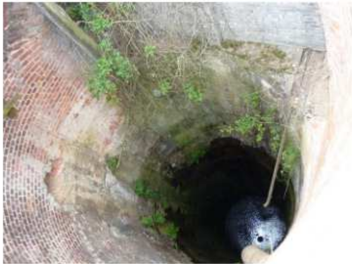
Photo 15 : Puits de Monteil
