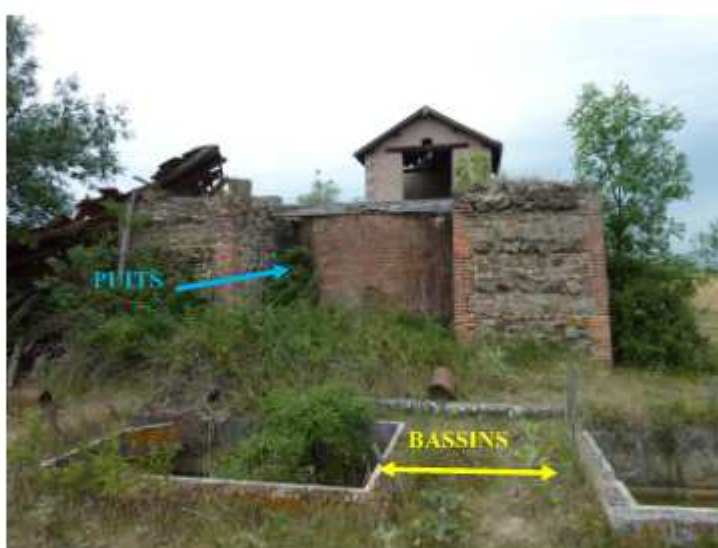
Photo 14 : Bassins de décantation et puits du Monteil
