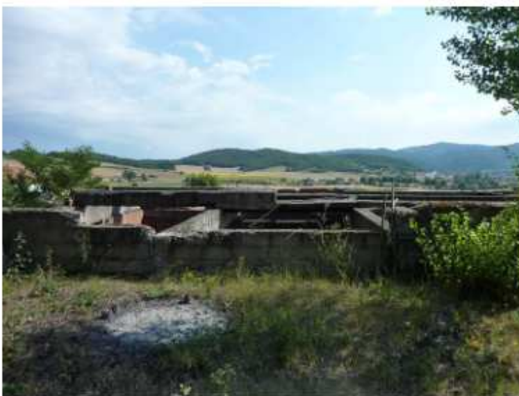
Photos 19 : Anciennes trémies – concession d'Armois
