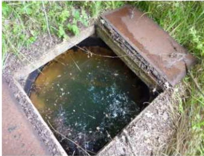
Photo 17 : Puits avec échelles, ennoyé et couvert par une plaque métallique
