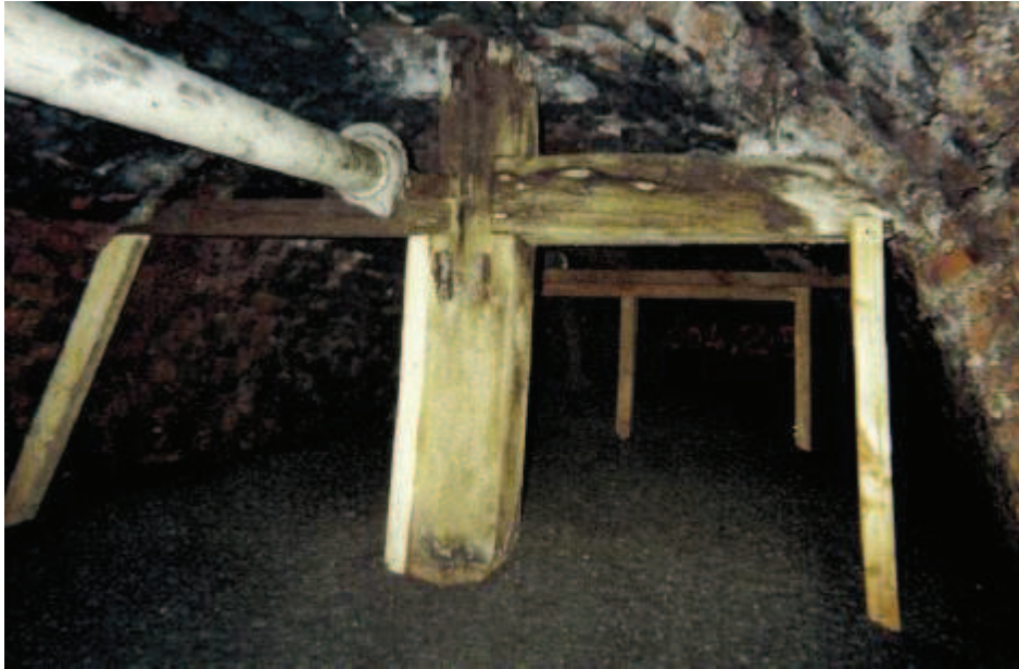
Photo 109 : Bétonnage de la galerie du Rouge
