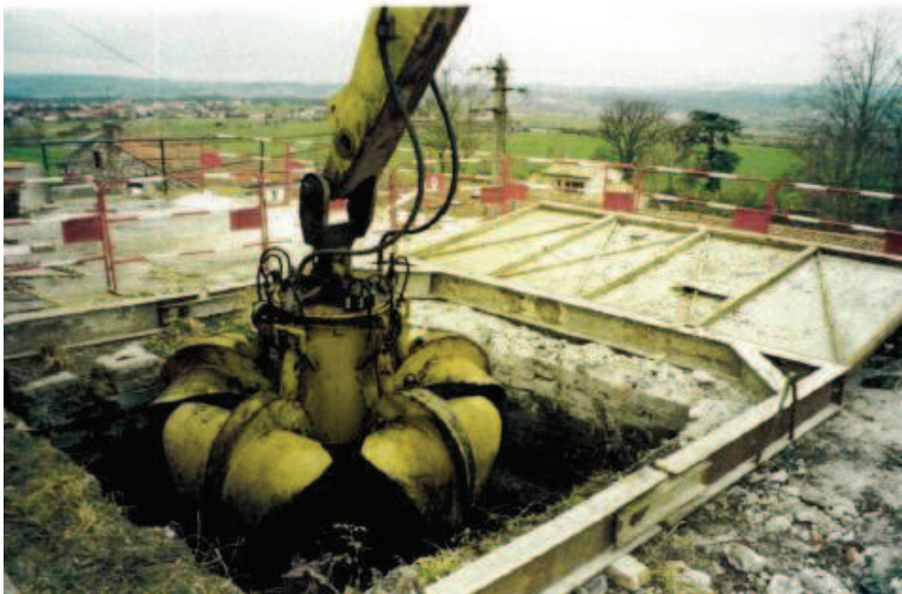
Photo 124 : Décaissement du puits de Coincy
