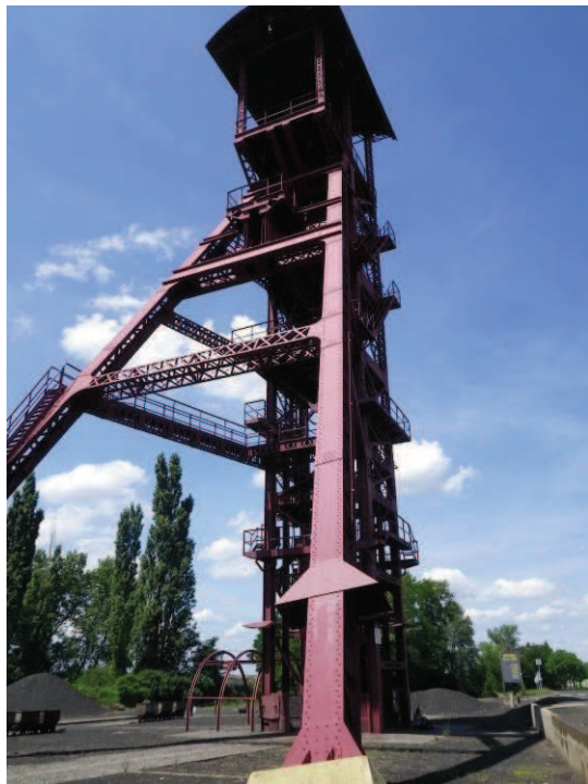
Photo 38 : Puits Bayard (P3) - Combelle
