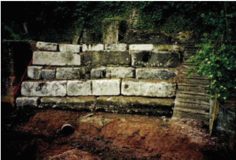
Photo 110 : Mur devant l'ancien accès de la galerie du Rouge
