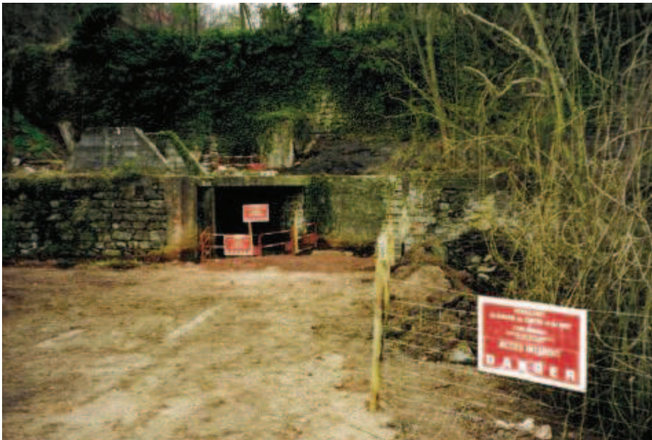
Photo 107 : Galerie du Rouge avant travaux
