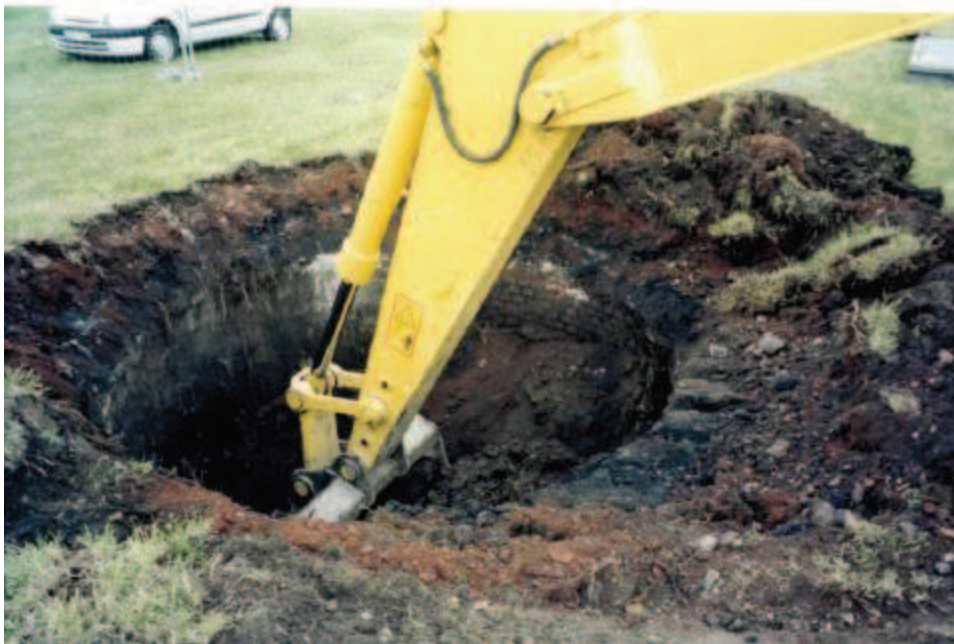
Photo 65 : Curage du puits Saint-Alexandre
