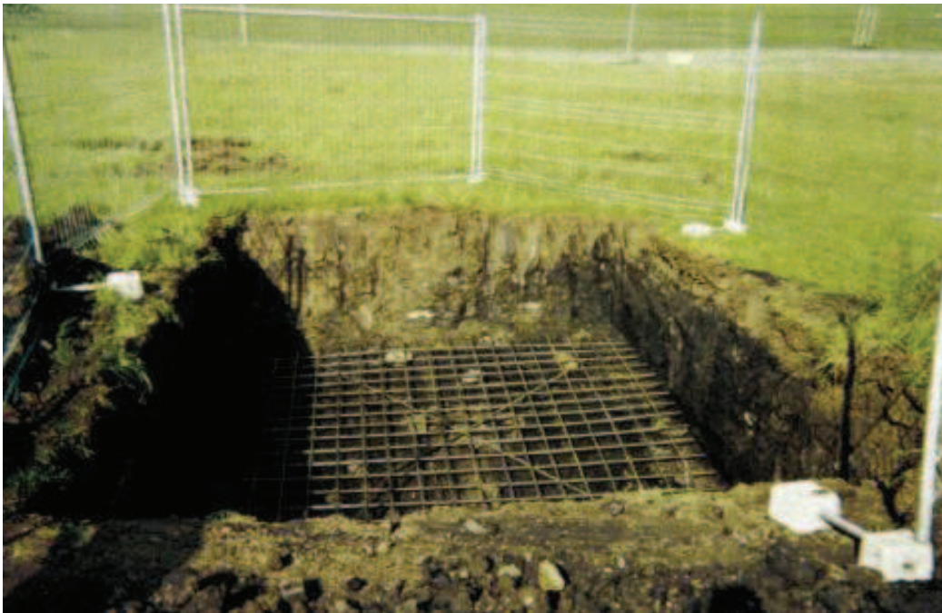
Photo 134 : Ferrailage de la dalle à l'aplomb du puits de recherche
