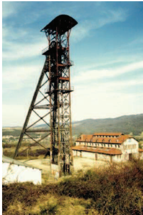
Photo 47 : Puits des Graves avant travaux
