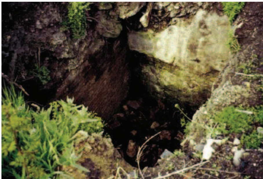
Photo 128 : Puits de la Cloche avant travaux
