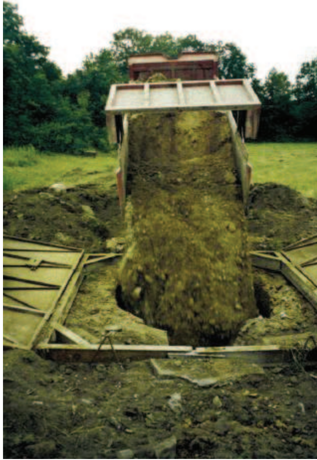
Photo 121 : Complément de remblais dans le puits de Chamblève
