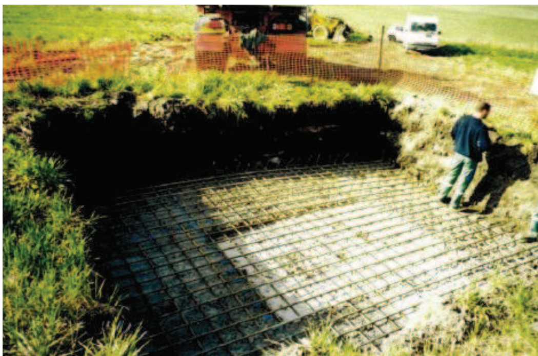
Photo 129 : Bouchon béton et ferrailage du puits de La Cloche
