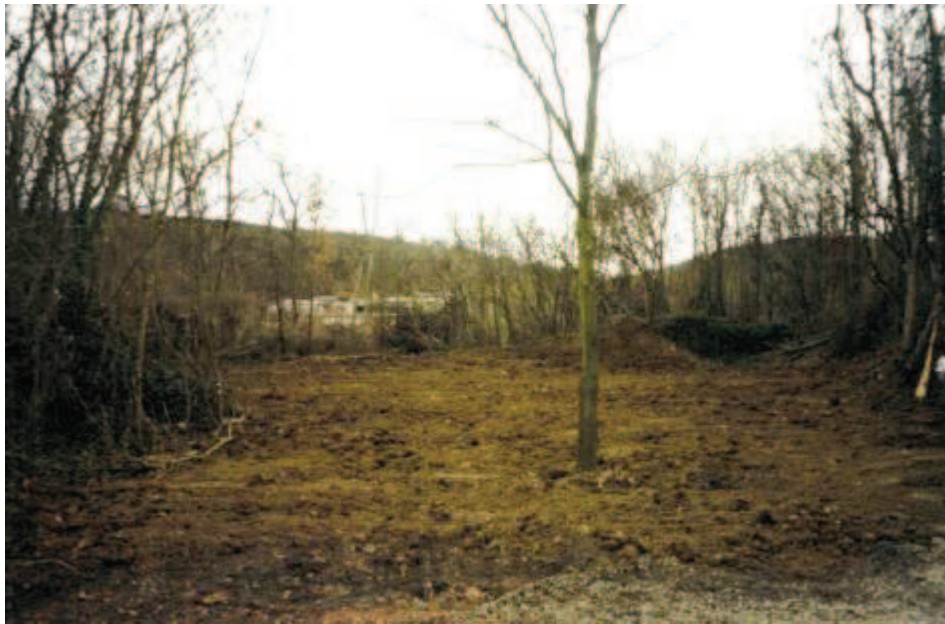
Photo 90 : Site du puits Denières après travaux
