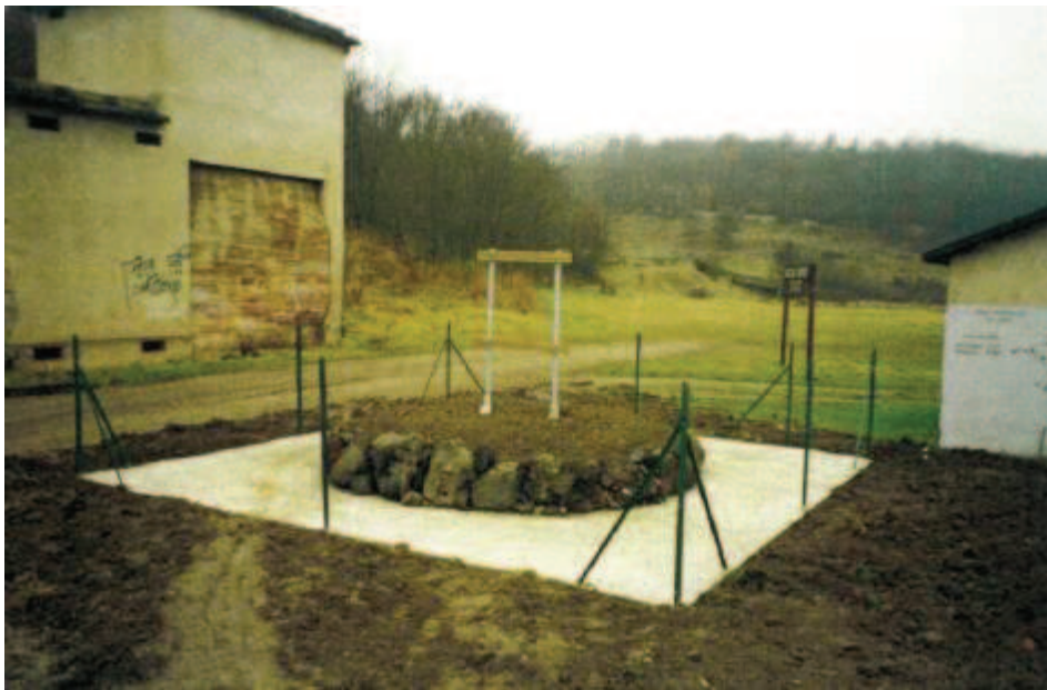
Photo 96 : Puits du Parc après travaux
