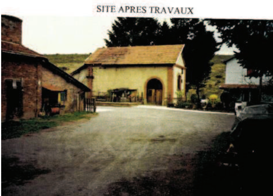
Photo 99 : Site du puits Morny après travaux
