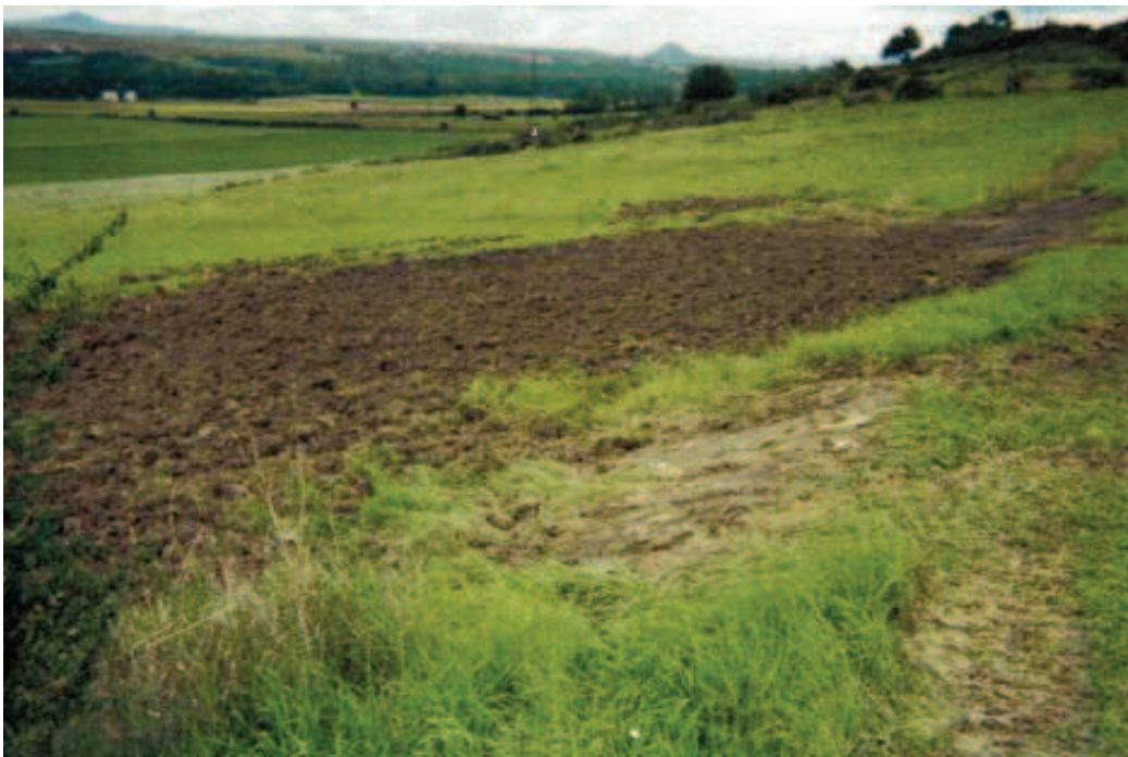
Photo 135 : Site du puits de recherche après travaux
