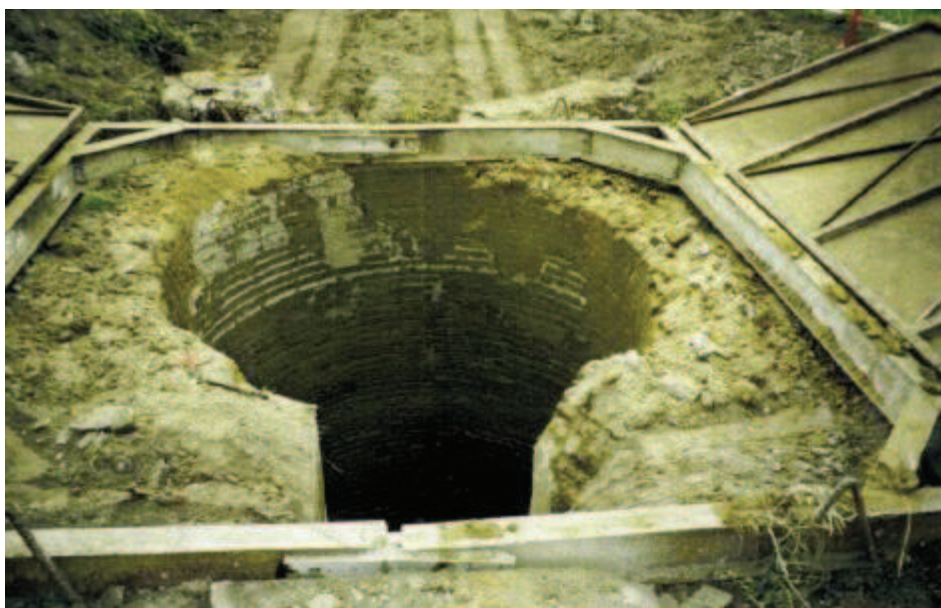
Photo 120 : Puits de Chamblève avant travaux
