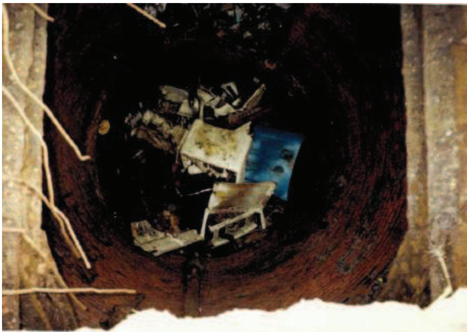
Photo 102 : Puits de l'Ouest avant travaux
