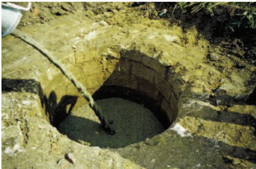
Photo 100 : Coulage du bouchon béton du puits du Feu
