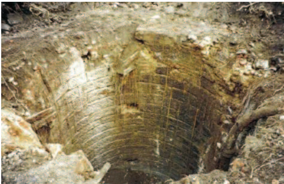
Photo 88 : Puits Denières avant travaux
