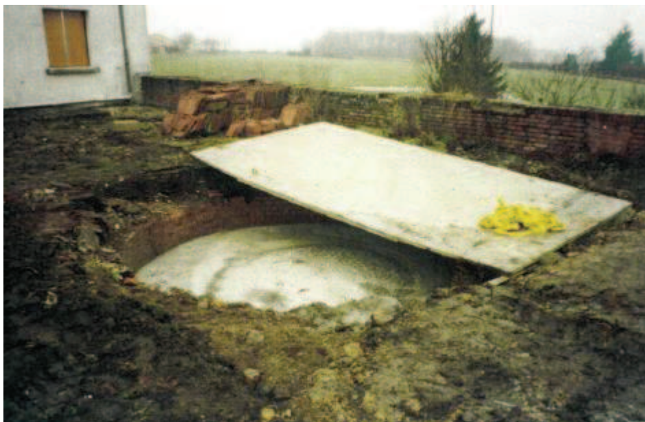
Photo 105 : Bouchon béton du puits de l'Ouest
