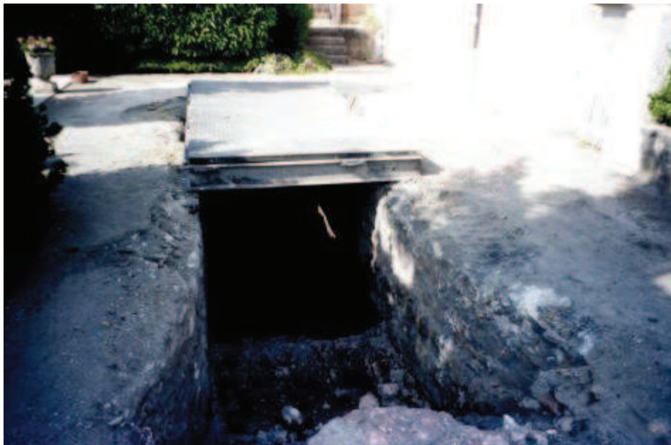
Photo 55 : Recherche du puits de la Verrerie
