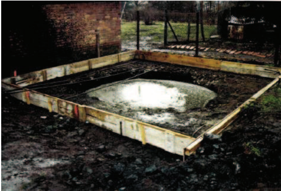
Photo 98 : Coulage du bouchon béton du puits Morny
