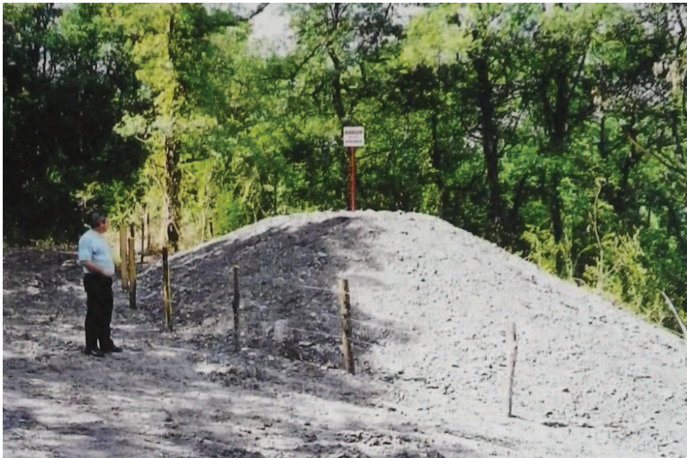
Photo 142 : Puits Sabatier après travaux
