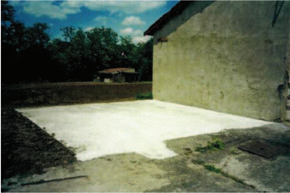
Photo 126 : Dalle en béton armé à l'aplomb du puits de Coincy
