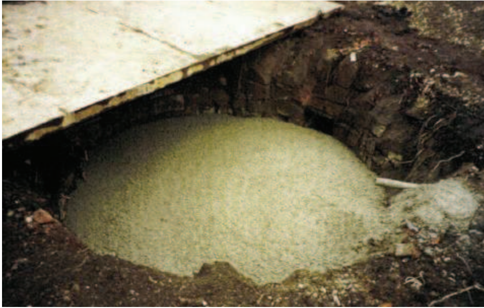
Photo 89 : coulage du bouchon béton du puits Denières
