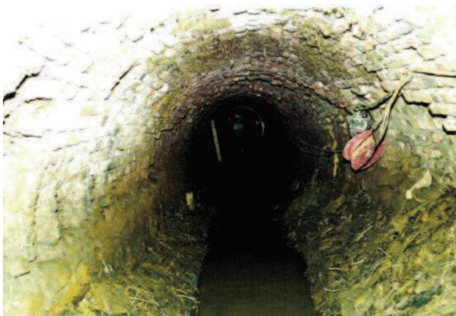
Photo 79 : Tunnel de Fondary avant travaux
