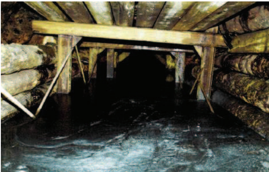
Photo 82 : Embouage du tunnel de Fondary (vue intérieure)
