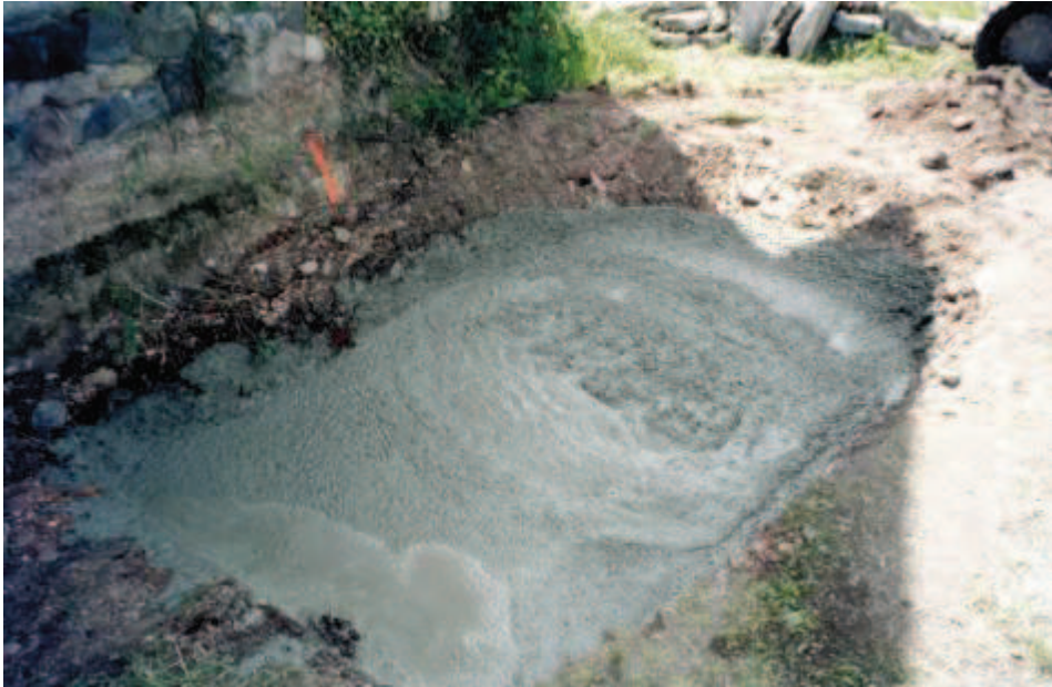
Photo 71 : Remblayage en béton de la galerie d'aérage 2
