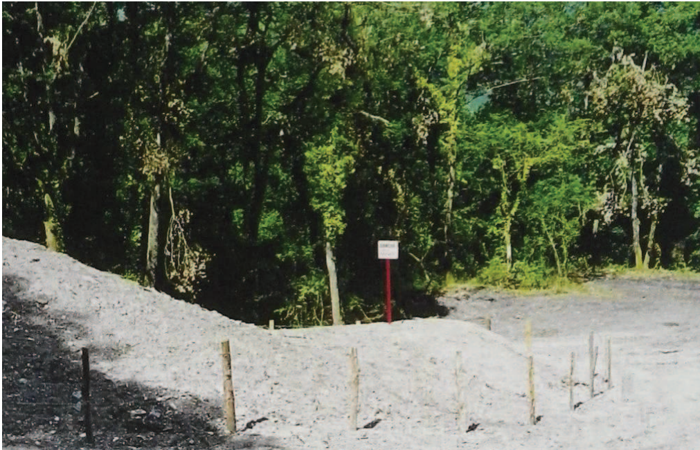
Photo 141 : Puits des Echelles après travaux
