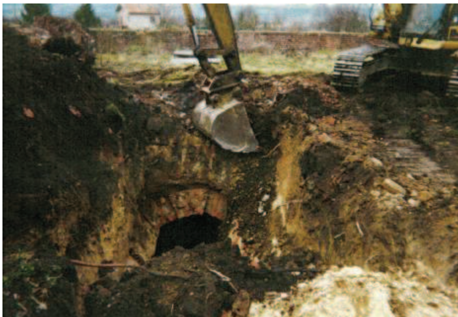
Photo 103 : Démolition de la galerie d'aérage
