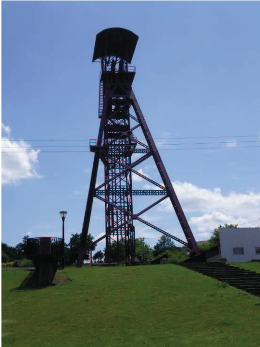
Photo 39 : Puits des Graves (P9) - Combelle
