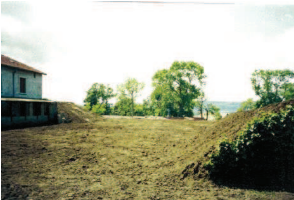
Photo 127 : Site du puits de Coincy après travaux
