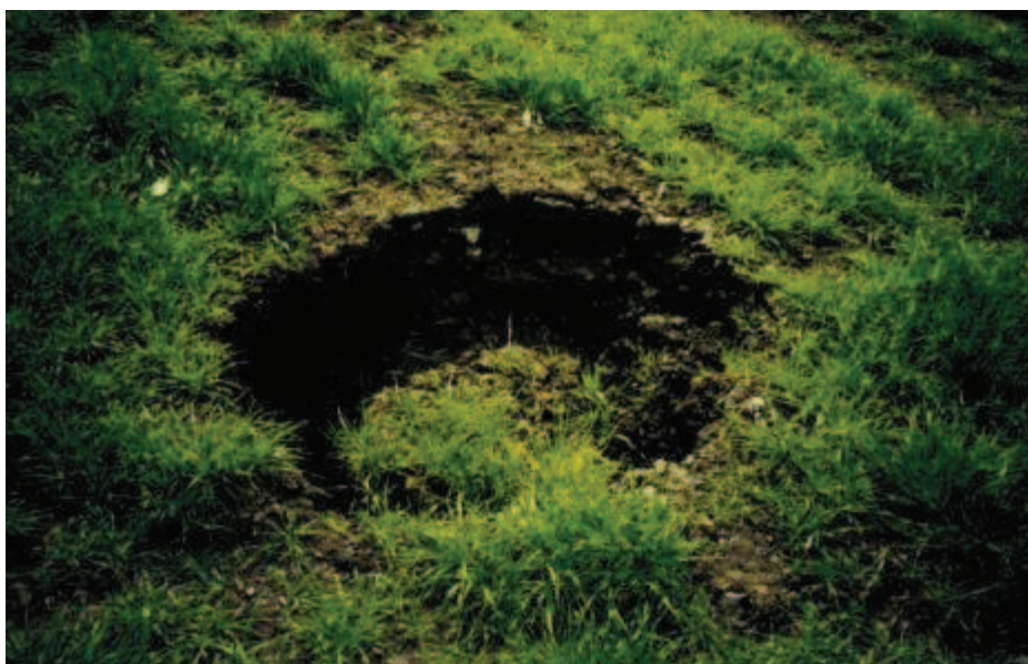
Photo 130 : Puits de la pompe avant travaux
