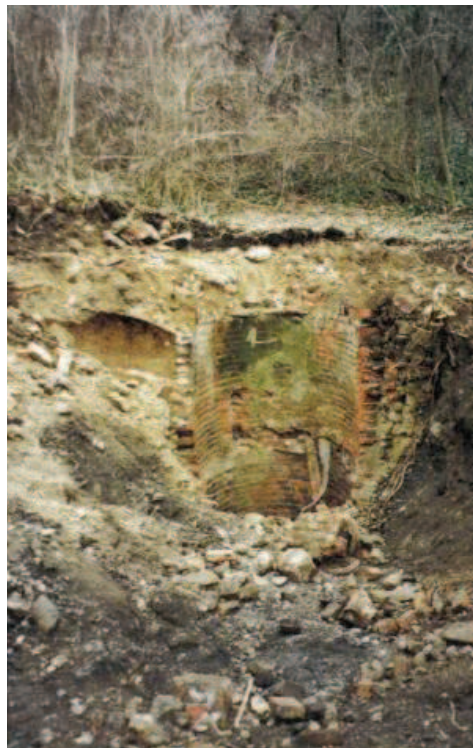
Photo 91 : Puits des Echelles avant travaux
