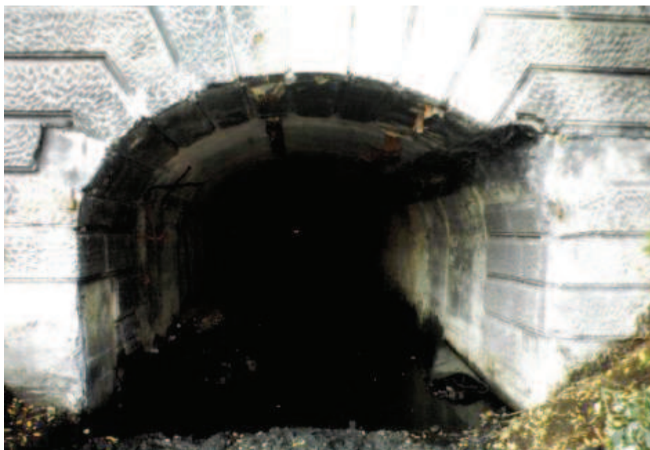
Photo 61 : Tunnel du puits des Graves avant travaux
