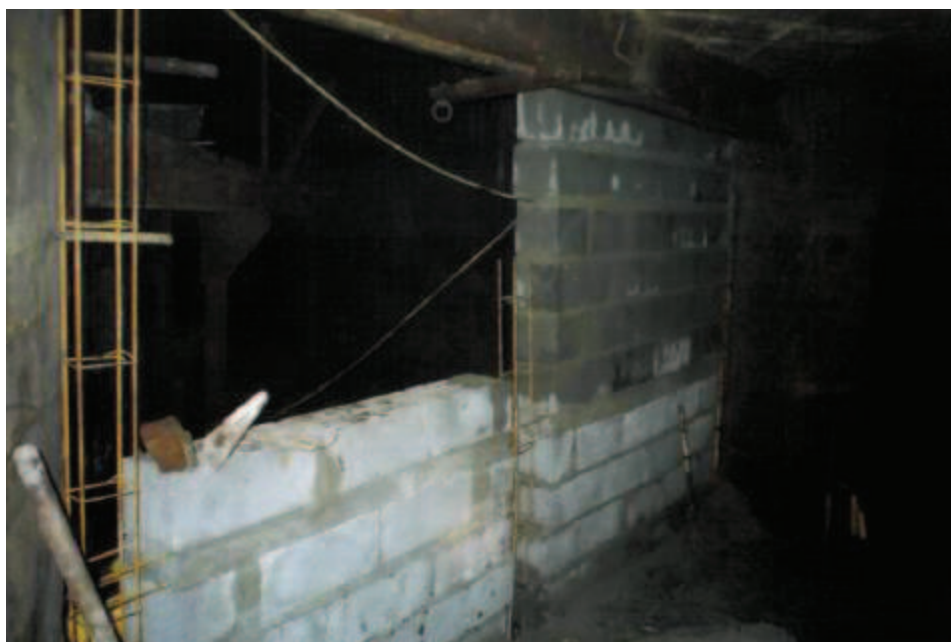
Photo 62 : Mise en place de murs étanches dans le tunnel du puits des Graves
