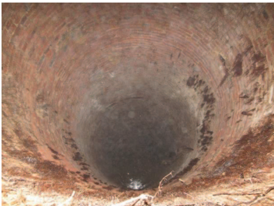
Photo 46 : Vue de l'intérieure du puits de Frugères
