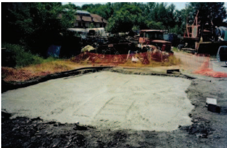
Photo 54 : Mise en place de la dalle béton du puits de Basse-Combelle
