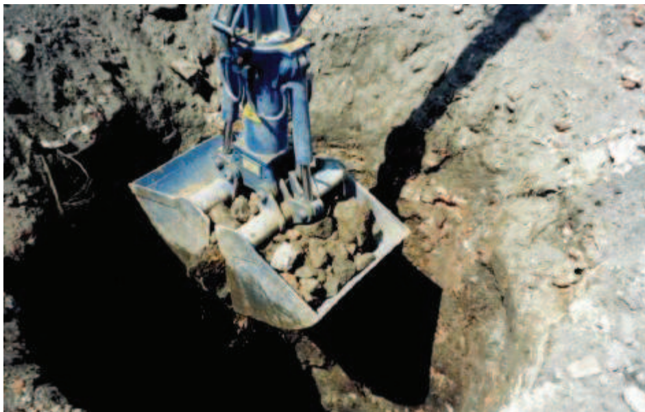
Photo 52 : Curage du puits de Basse-Combelle
