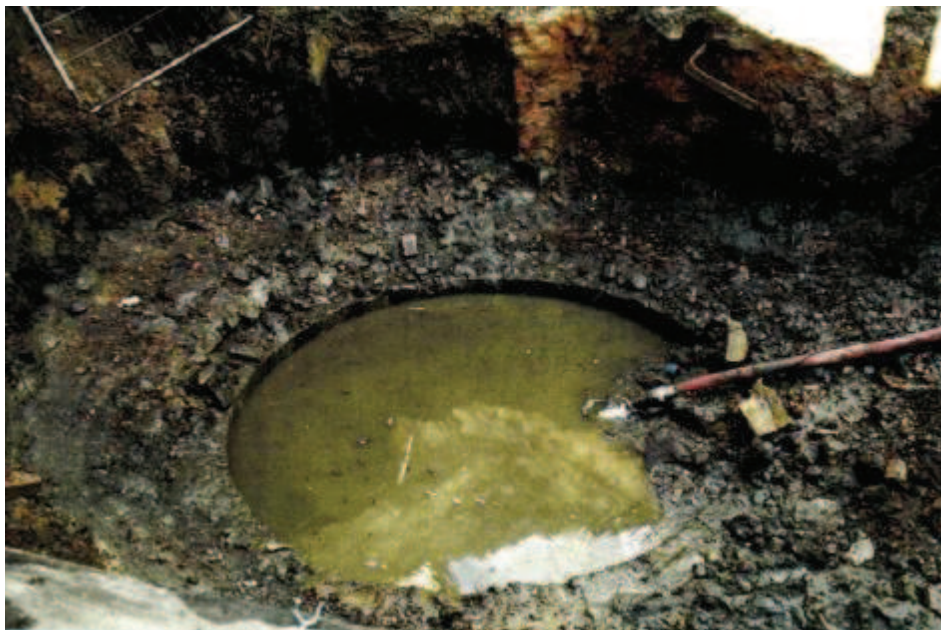
Photo 77 : Orifice du puits d'aération n°2
