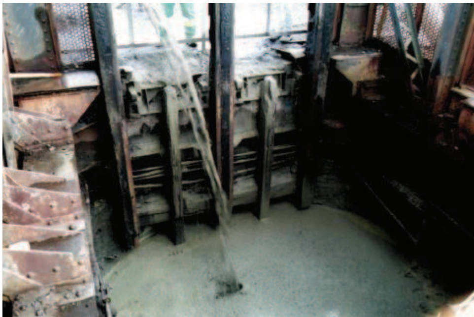
Photo 50 : Coulage du bouchon béton du puits Bayard
