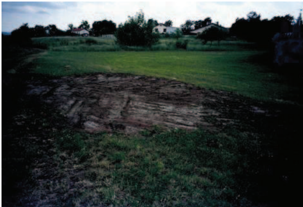
Photo 67 : Site du puits Saint-Alexandre après travaux
