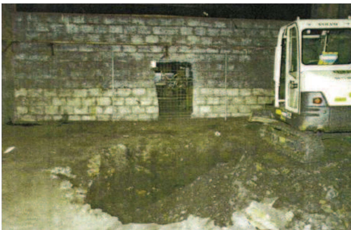
Photo 137 : Puits de Grosménil avant travaux
