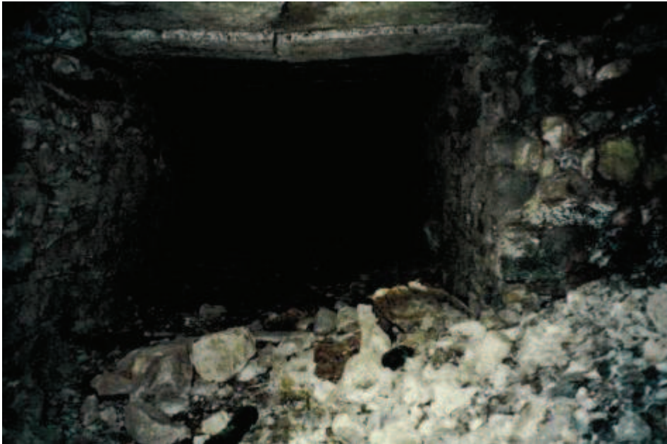
Photo 85 : Etat de la galerie Denières avant travaux
