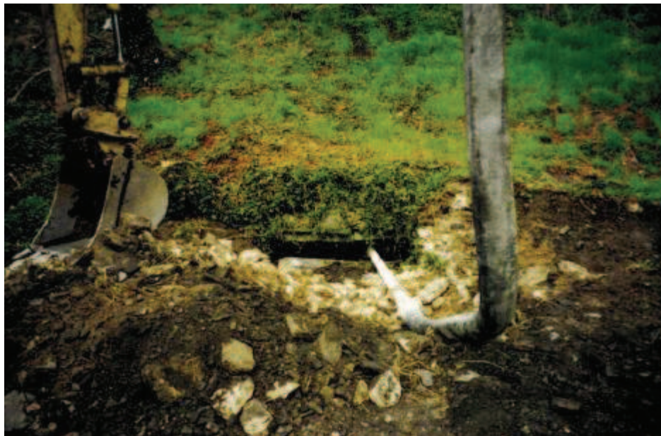
Photo 86 : Coulage du béton dans la galerie Denières
