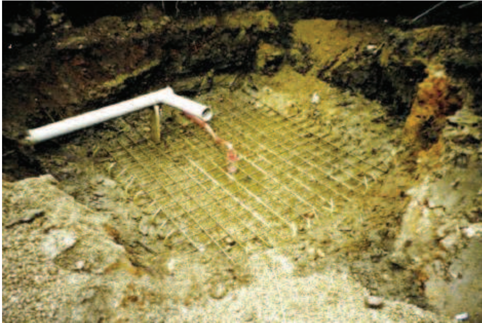
Photo 78 : Ferrailage de la dalle du puits d'aération n°2
