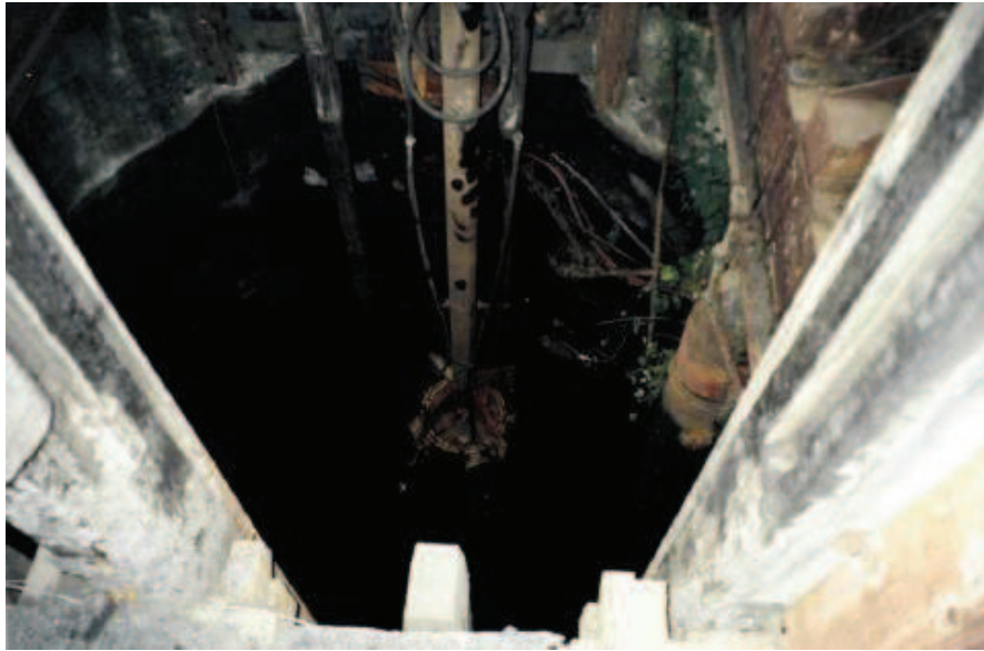
Photo 48 : Curage du puits des Graves
