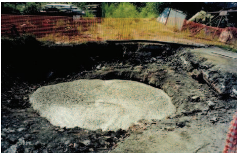
Photo 53 : Coulage du bouchon béton au puits de Basse-Combelle
