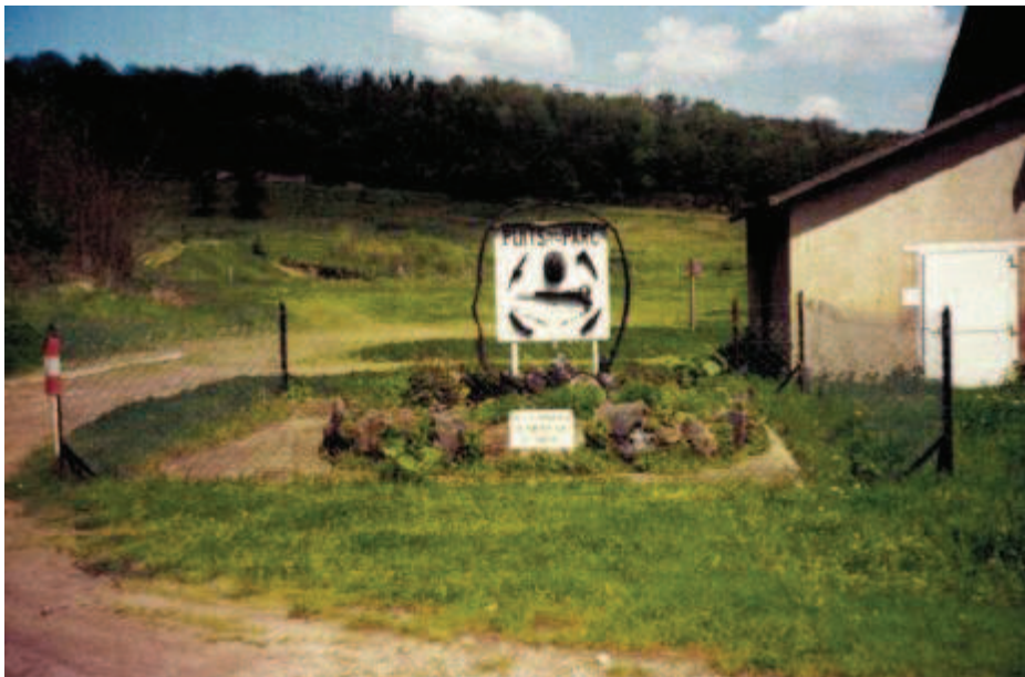
Photo 94 : Puits du Parc avant travaux
