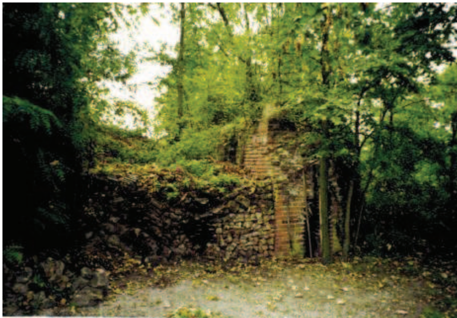
Photo 123 : Site du puits de Coincy avant travaux
