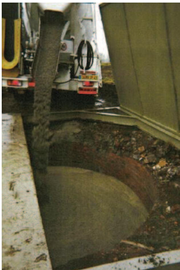
Photo 104 : Coulage du bouchon béton du puits de l'Ouest
