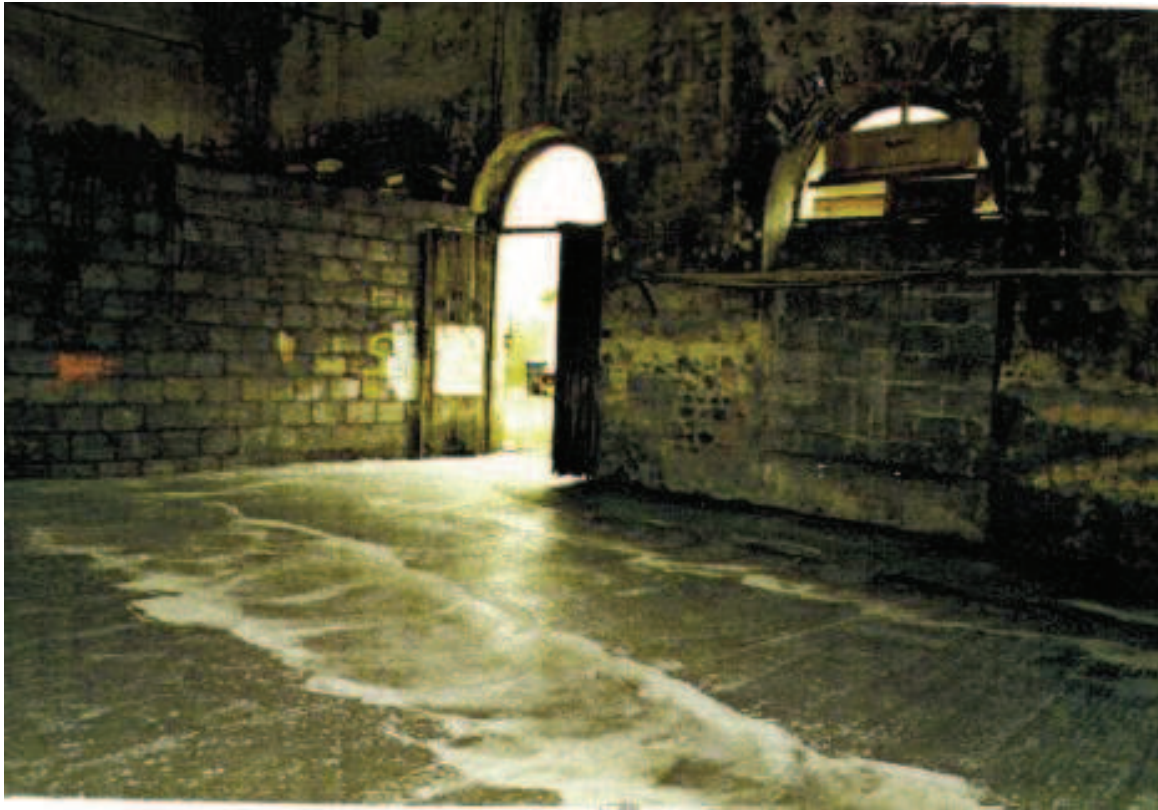
Photo 140 : Puits de Grosménil après travaux
