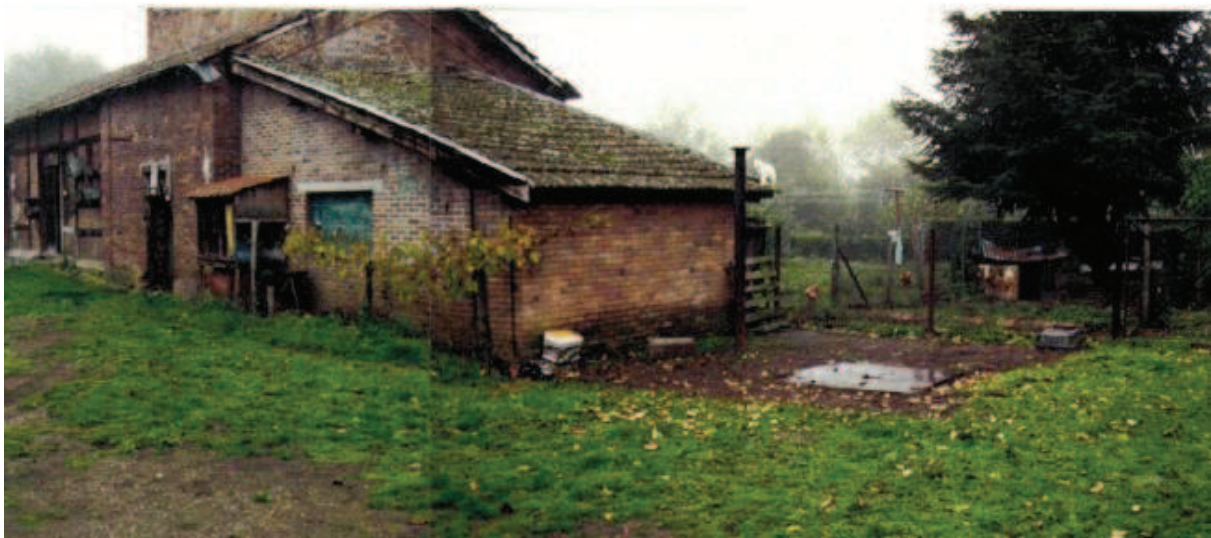
Photo 97 : Puits Morny avant travaux
