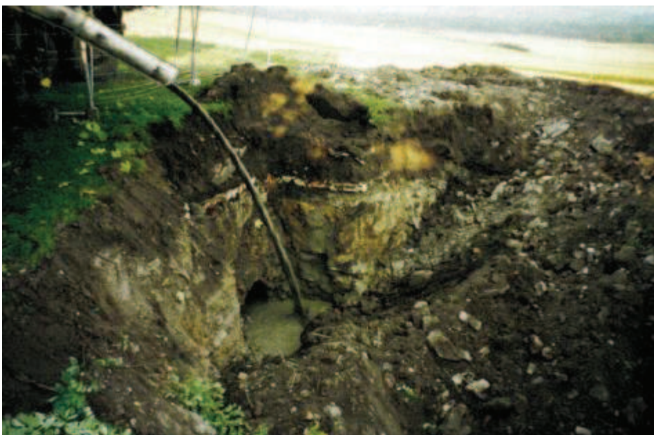
Photo 118 : Bétonnage de la galerie d'accès au puits du Président
