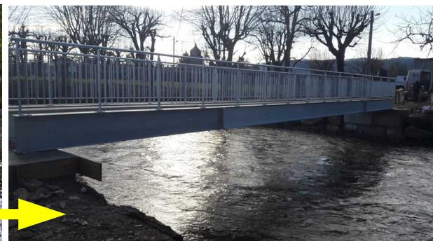
Suppression d'une passerelle constituée de 11 buses par une passerelle posée sur deux piliers sur la Dore à Marsac-en-Livradois
