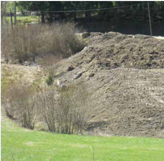
Remblai en partie en zone humide
