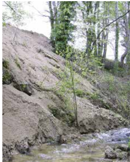
Remblai instable avec des conséquences sur le colmatage du cours d'eau
