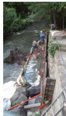
Réfection de berges
