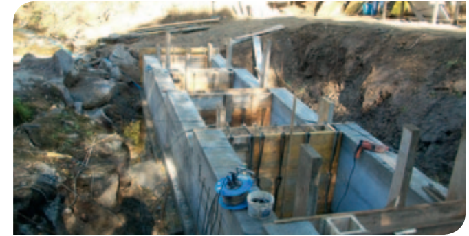
Passe à bassins en construction
